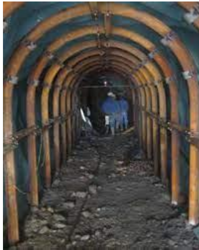
Figura 1.5 Fortificación con marcos de acero
