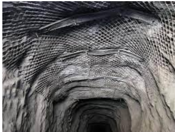
Figura 1.6 Fortificación con mallas de acero
