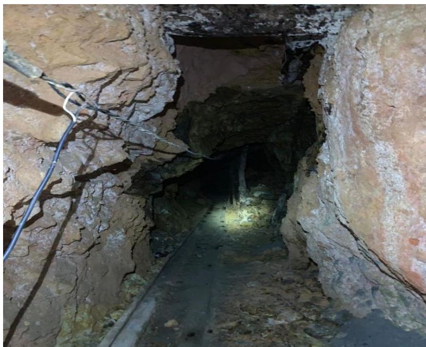
Anexo 2: Tramo del túnel estudiado
