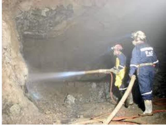
Figura 1.7 Fortificación por shotcrete
