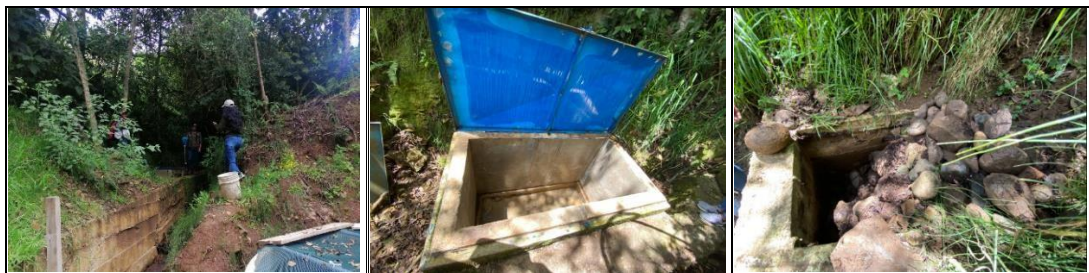
Figura 2.1. Captaciones del proyecto.
