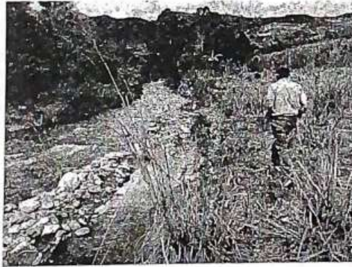
Figura 1: Captación del sistema de riego Taxiche – El Vergel – Santa Ana.
