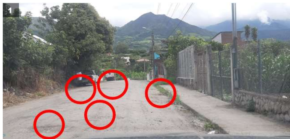
Parte inicial del tramo 1
