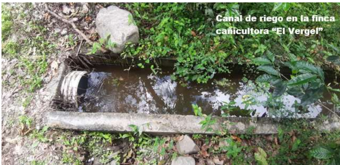
Parte inicial del canal de riego de la Finca Cañicultora “El Vergel”
