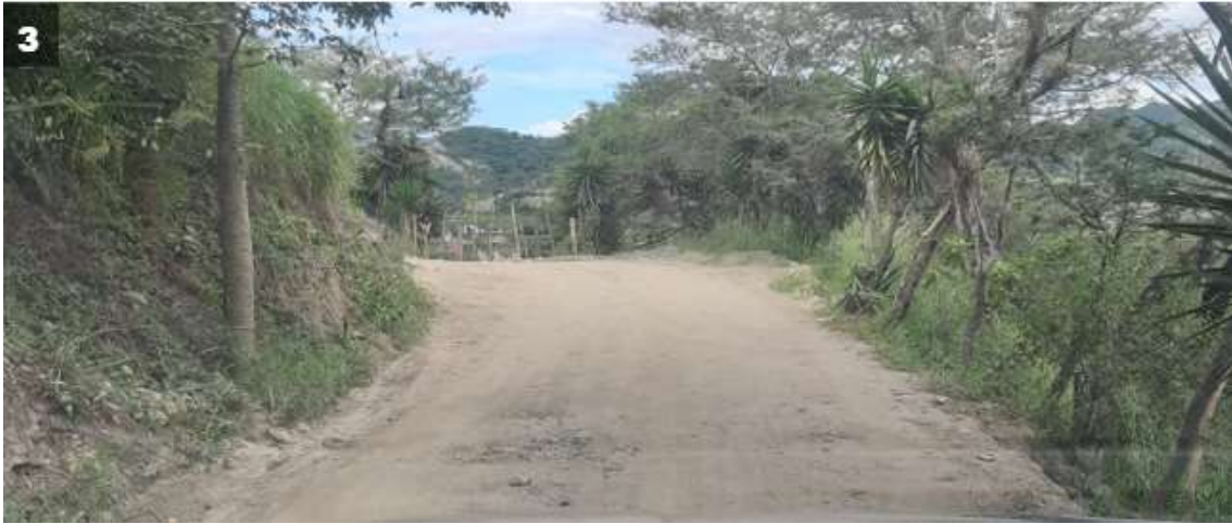
Estado de la vía en el sector 3
