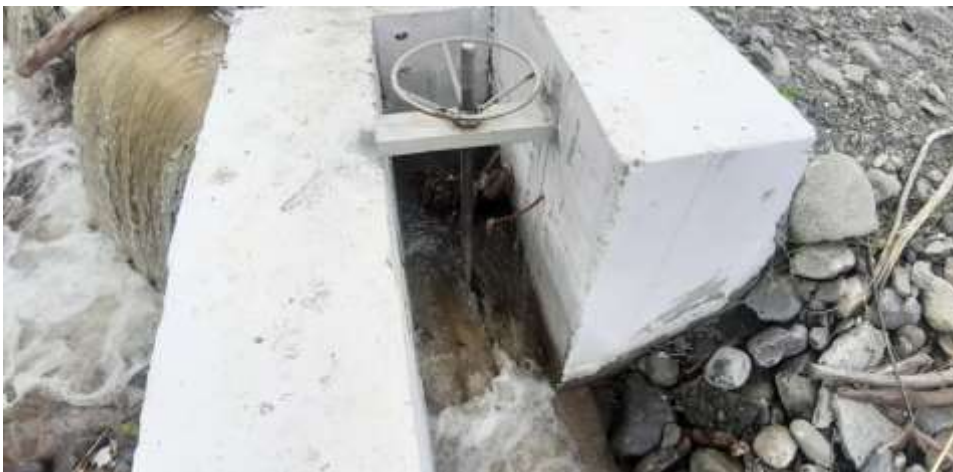
Estado de la valvula de la bocatoma, 11 de febrero del 2023
