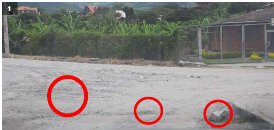
Parte final del tramo 1
