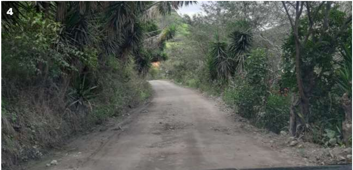
Estado de la vía en el sector 4
