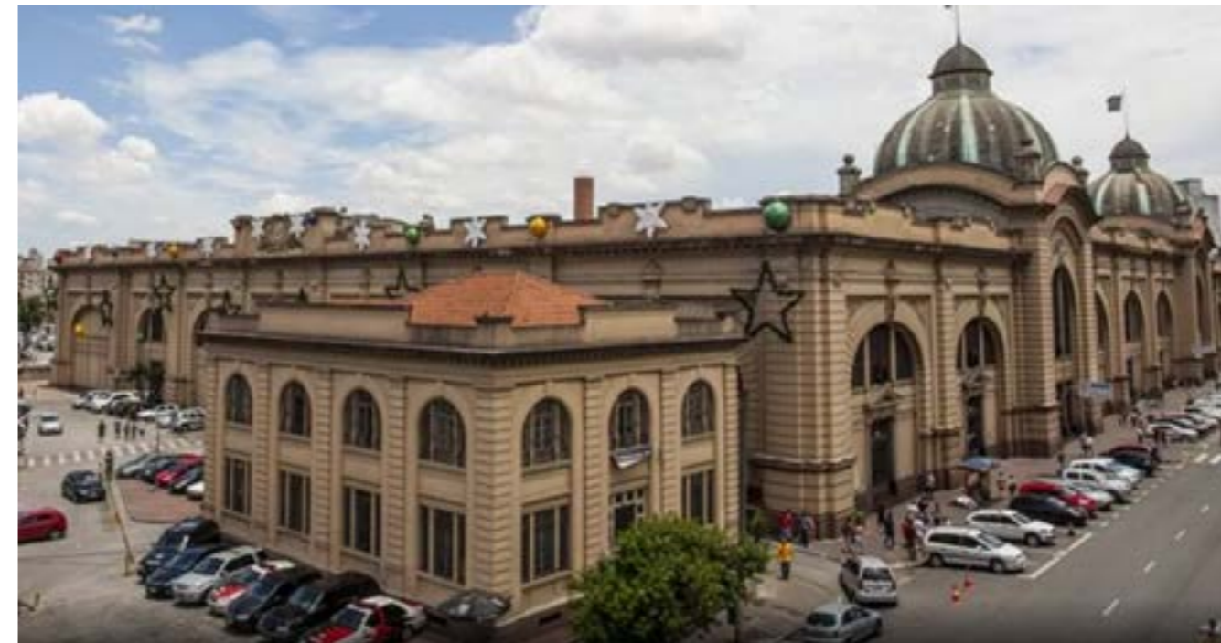
IMG 54, 55 Vista aérea Mercado Municipal de São Paulo / Fuente: Vagner Campos, 2022.
