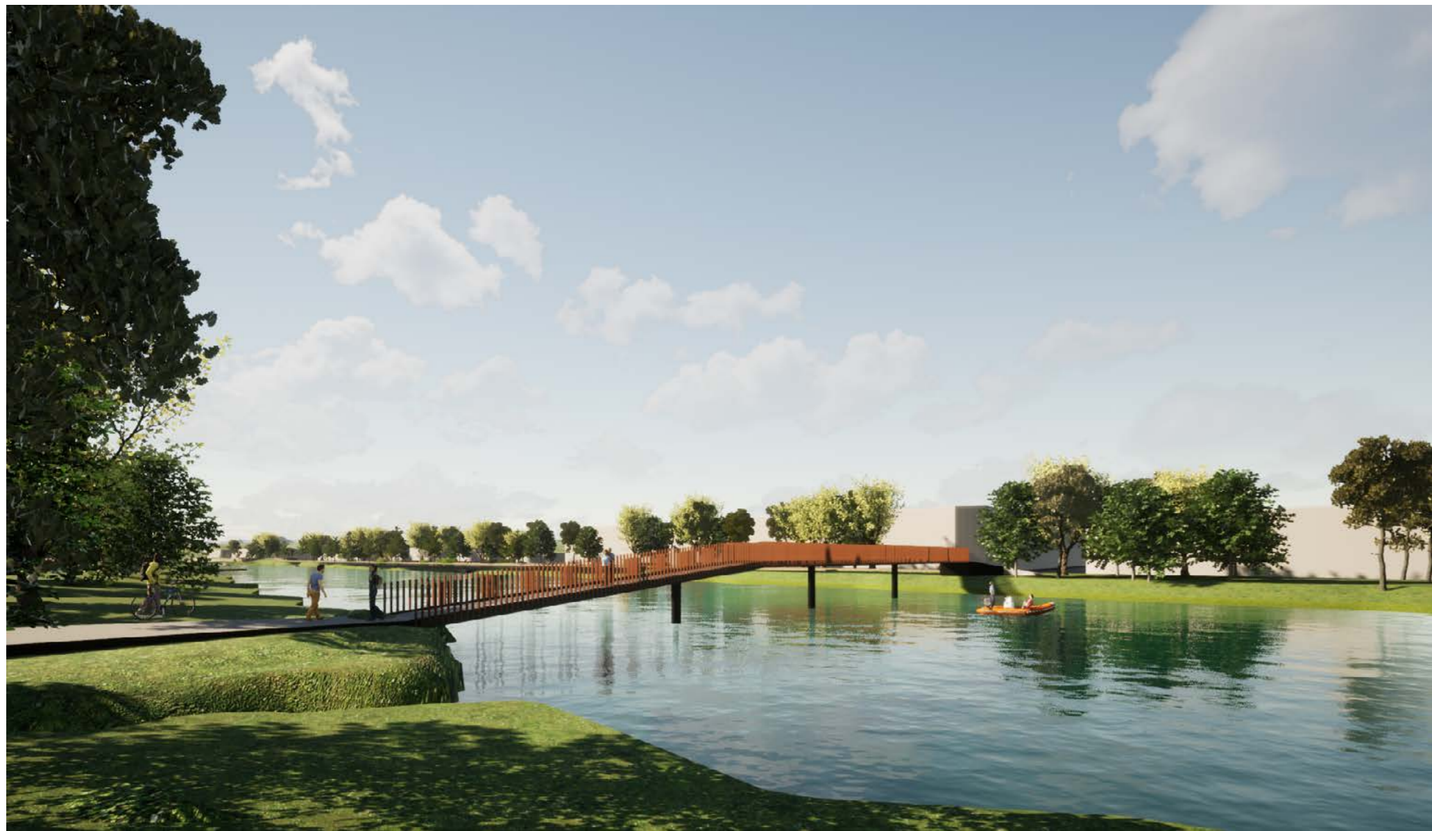
IMG 52. Puente peatonal - conexión entre la zona de depuración de aguas y la Concha Acústica.
