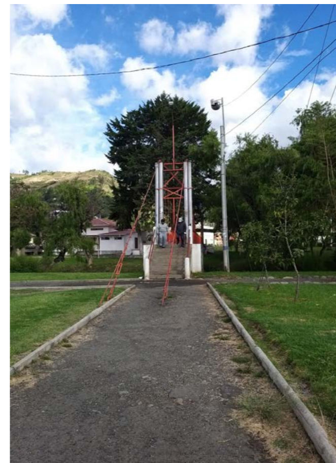
IMG 09. Puente peatonal como conexión, imagen de autoría propia.
