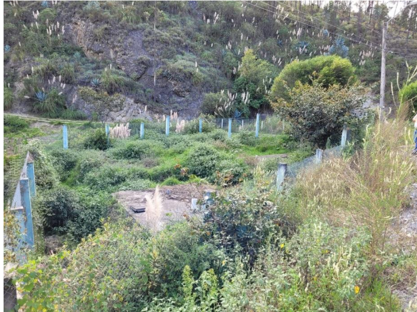
Ilustración 1.4 Estado de la planta de tratamiento de aguas residuales
