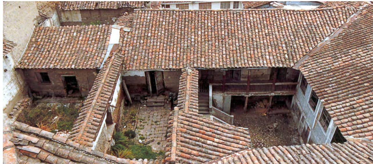
Fig. 13. Casa 7 Patios antes de la rehabilitación Fuente: Manuel Ramos Guerra (2009)
