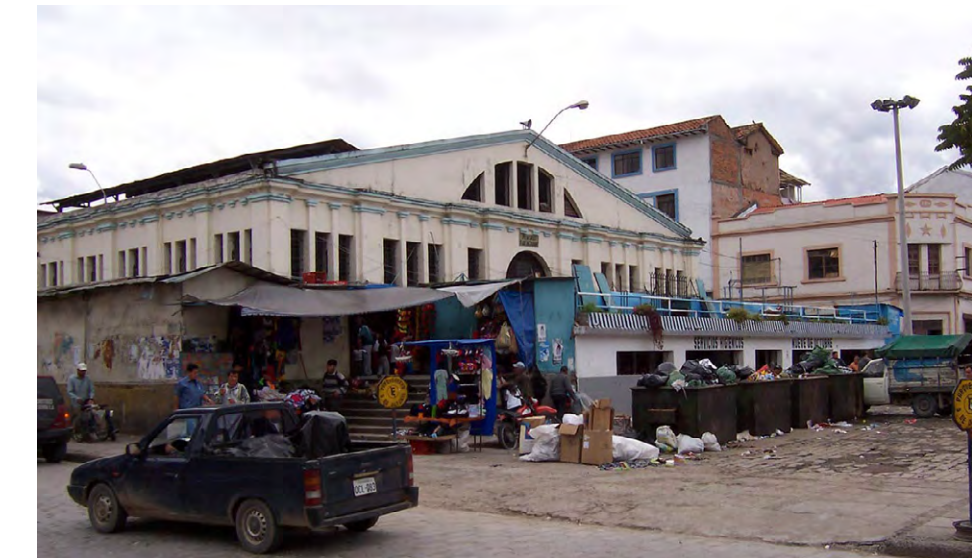
Fig. 23. Mercado 9 de Octubre antes de la rehabilitación: comercio informal, basura. Fuente: Rehabilitación del Mercado 9 de Octubre (2010)
