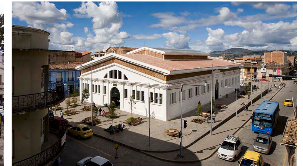
Fig. 24. Mercado 9 de Octubre después de la rehabilitación. Fuente: Rehabilitación del Mercado 9 de Octubre (2010)
