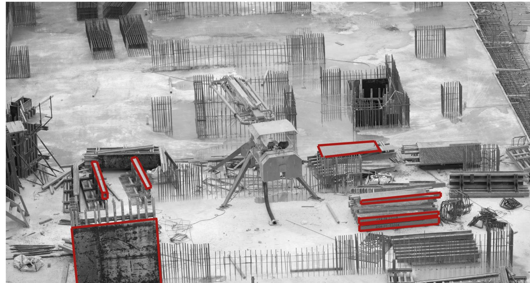
Figura 15: Organización de elementos prefabricados en obra. Fuente: (Enging Akyurt, s. f.)
