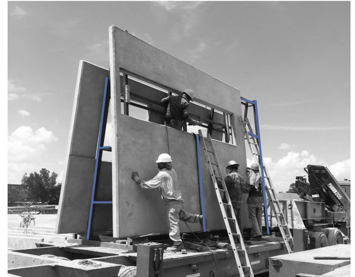
Fig 26 : Sujeción de paneles mediante correas a caballetes de transporte. Fuente: (Constructora QUID . s. f.)
