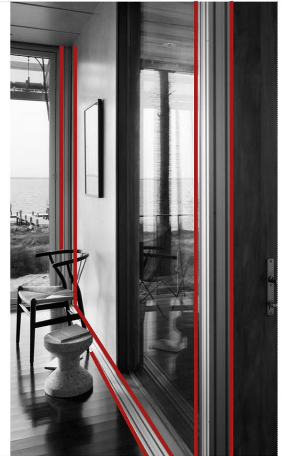
Fig 82: Acabado resultante de la instalación de paneles de la envolvente por el exterior de los perfiles metálicos. Fuente: (Halkin Photography LLC, s. f.)
