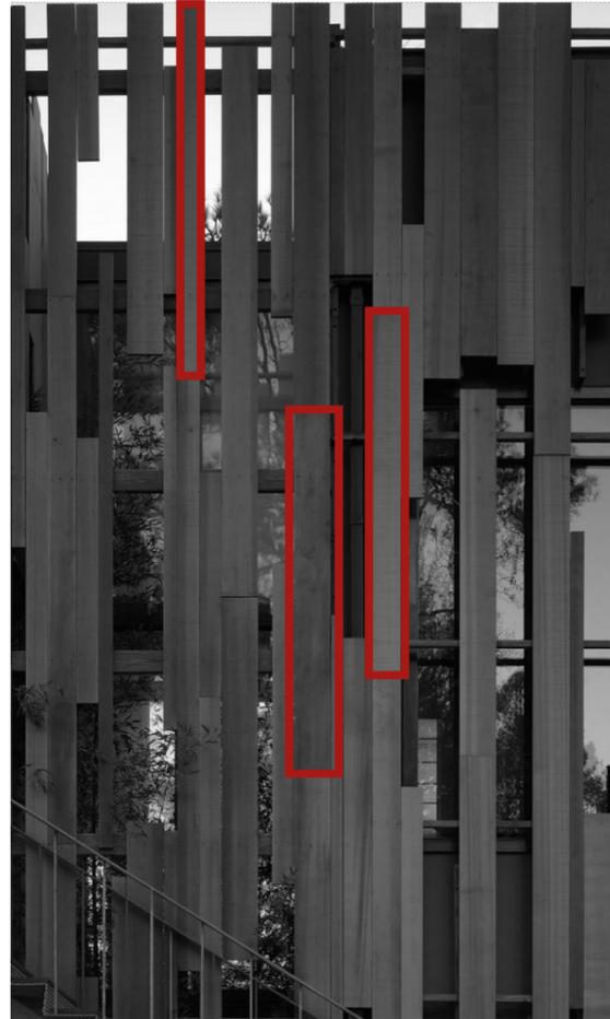
Fig 79: Revestimiento escalonado de madera. Fuente: (Halkin Photography LLC, s. f.)
