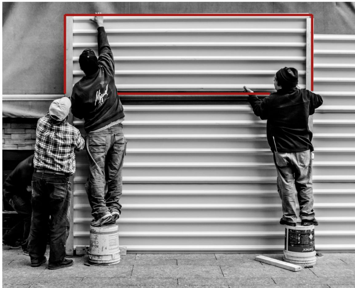
Fig 27 : Montaje manual de paneles. Fuente: (Aranxa Treva, s. f.)
