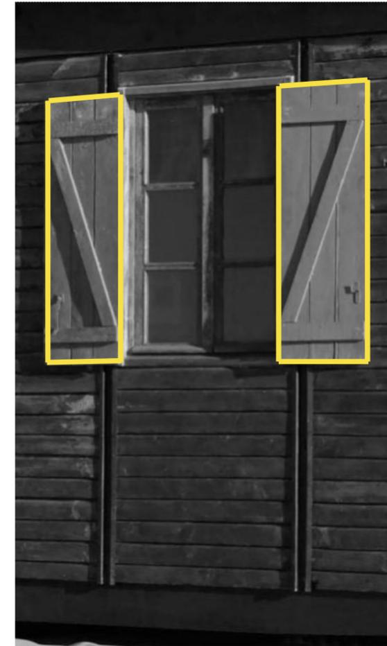
Figura 68: Cerramiento tipo batiente para ventanas de la obra.
