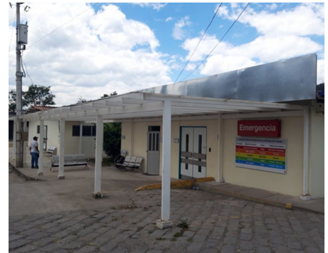
Imagen 3: Sala de espera de emergencia
