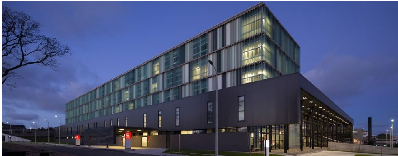
Imagen 23: Ingreso lateral a emergencia
