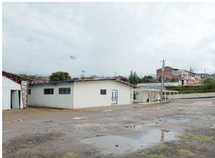
Imagen 1: Ingreso a emergencia y hospitalización
