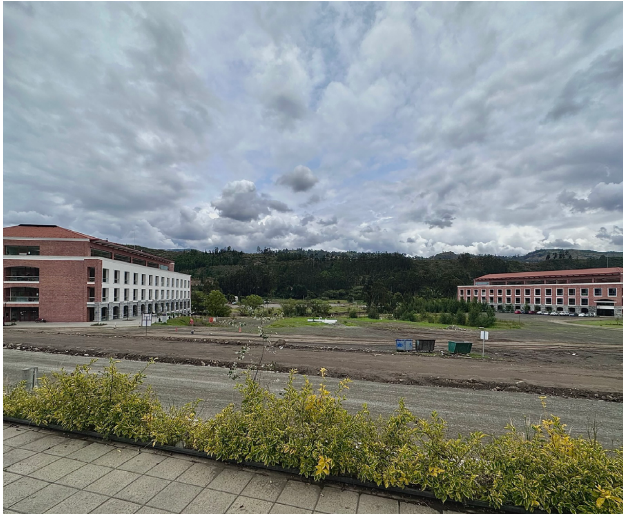
Figura 75. Aularios de la UNAE Fuente: Elaboración propia
