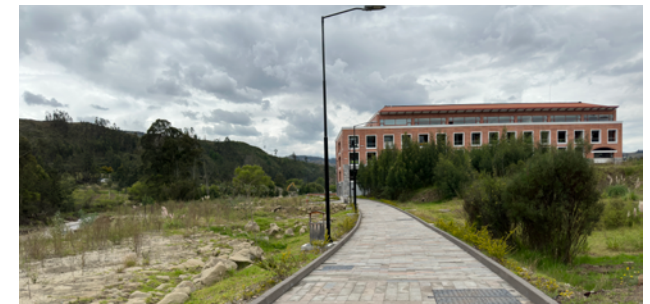
Figura 75. Aularios de la UNAE Fuente: Elaboración propia
