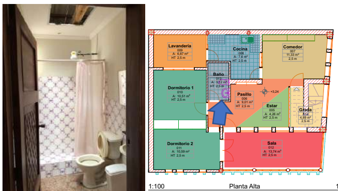
Figura 56 Vista de baño en Vivienda Seminario / Autor, 2023
