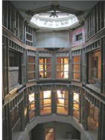
Figura 8 “The Church Lofts” atrio central en construcción / Benjamín Watt Meyer, 2009
