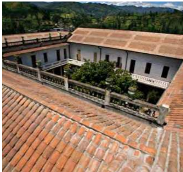
Figura 13 Vista desde la cubierta del Antiguo Hospital del Corazón de Jesús del Cantón Guaranda, Provincia Bolívar / Ministerio Coordinador de Patrimonio, 2009
