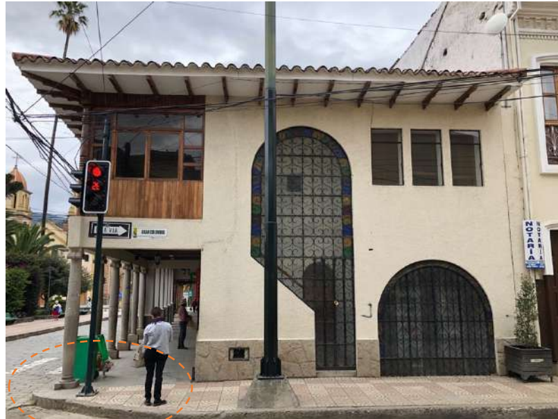
Figura 38 Vista lateral de Vivienda Seminario desde la calle Gran Colombia
