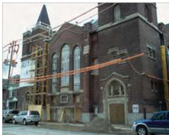
Figura 5 Lofts de la Iglesia en construcción (CJUC) / Nicholas Lynch, 2009
