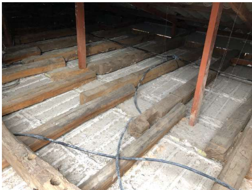
Figura 42 Vista interior de la cubierta Vivienda Seminario / Autor, 2023
