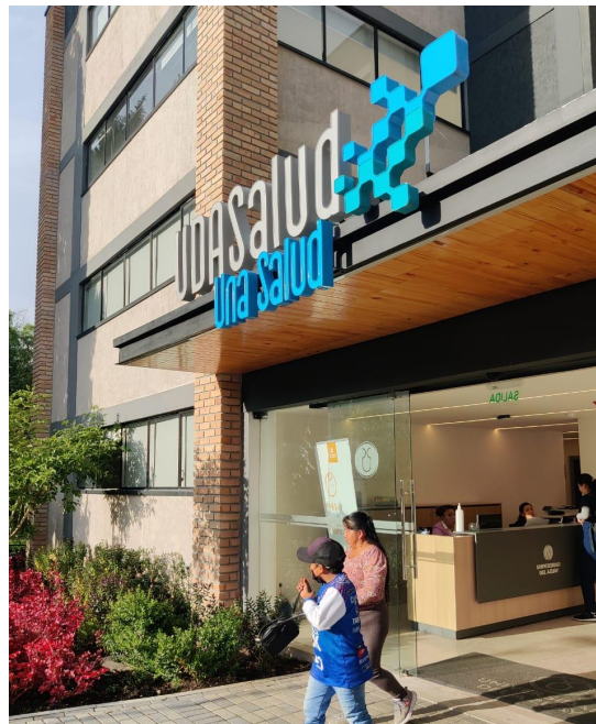
FIGURA 6: Fotografías de goterones (“EDIFICIO UDA SALUD)
