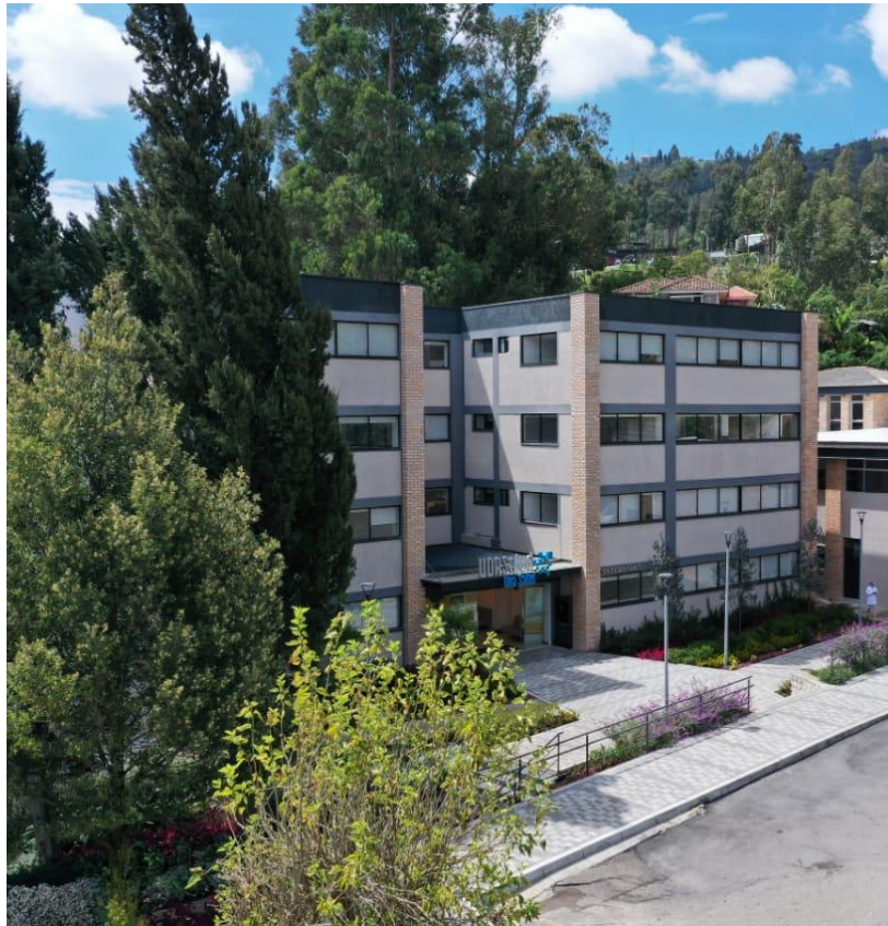
FIGURA 10:FOTOGRAFÍA DE DRONE DEL EDIFICIO (se observa la vegetación que rodea el edificio)
