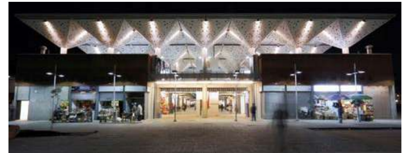
Fig 30. Fachada mercado. Fuente: archdaily.cl
