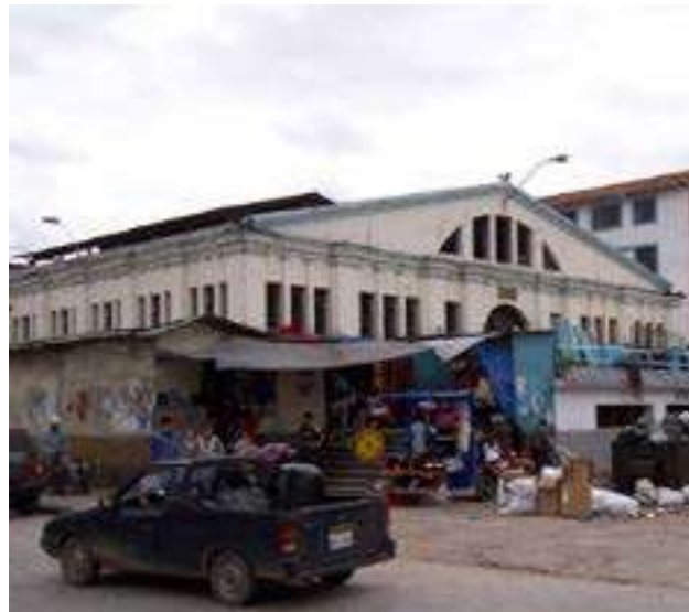
Fig 33. Mercado 09 de Octubre antes de la intervención. Fuente: Boris Albornoz
