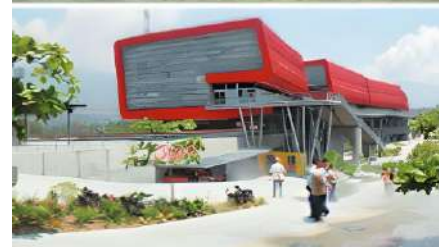
Fases de construcción Parque Explora
