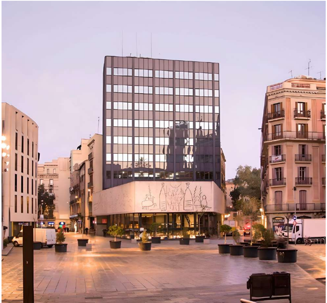
Fachada frontal del Colegio de Arquitectos de Cataluña COAC
