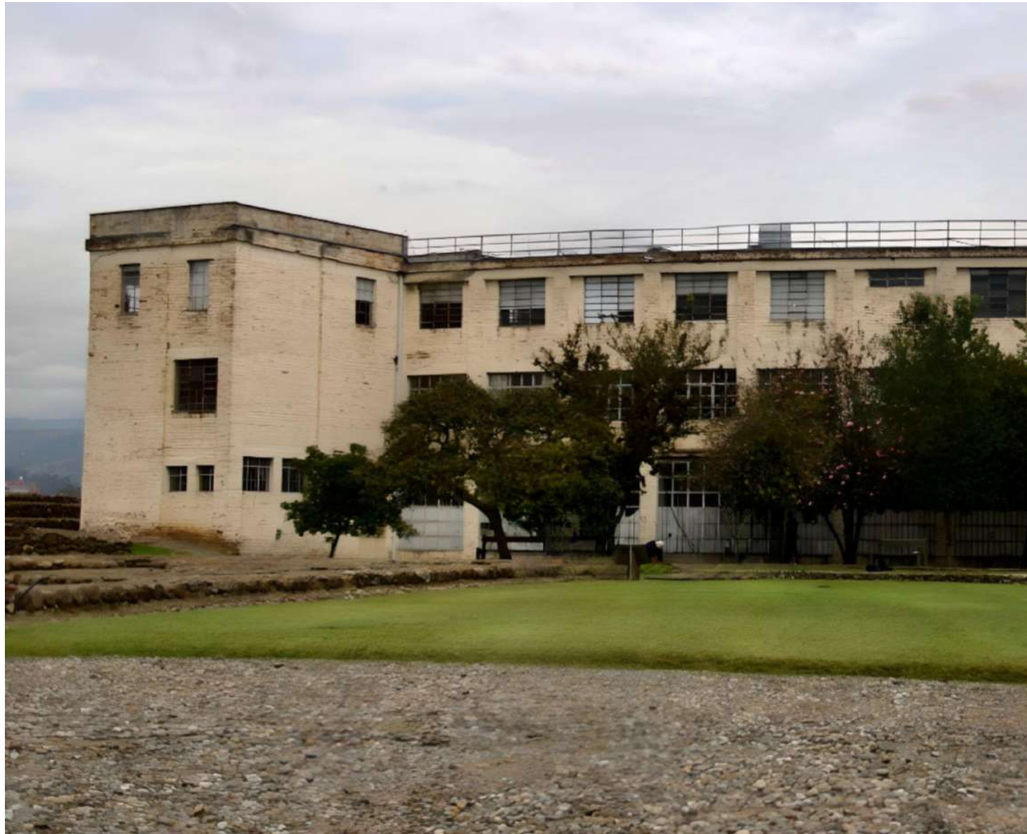
Complejo Pumapungo, bloque Ex-Borja.
