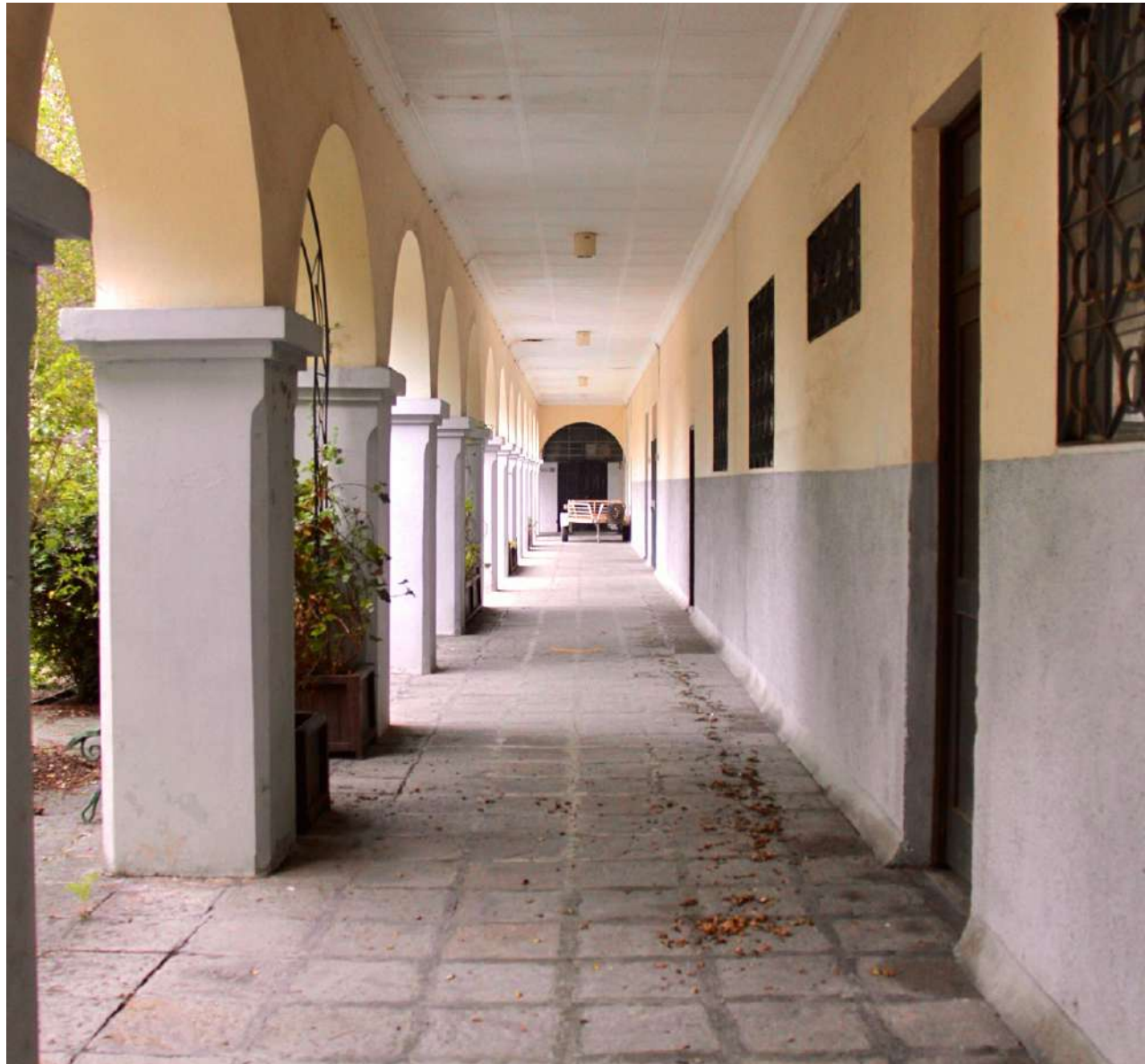
Interior del antiguo edificio del colegio Borja
