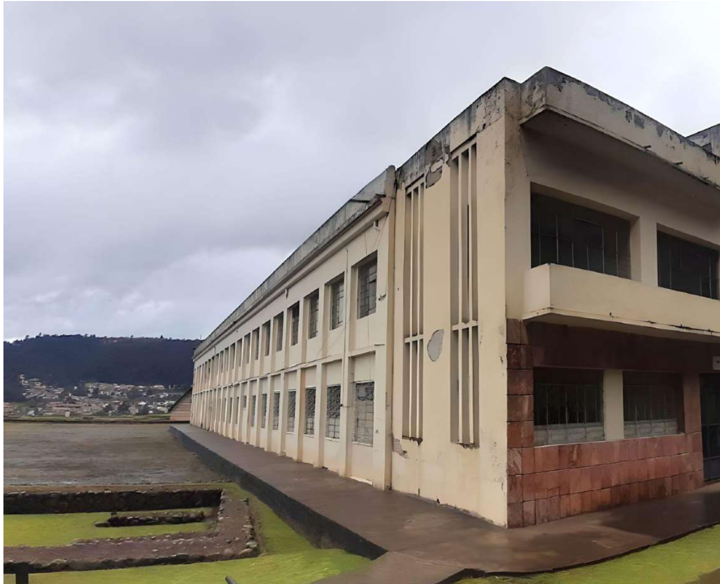
Complejo Pumapungo, bloque Ex-Borja.
