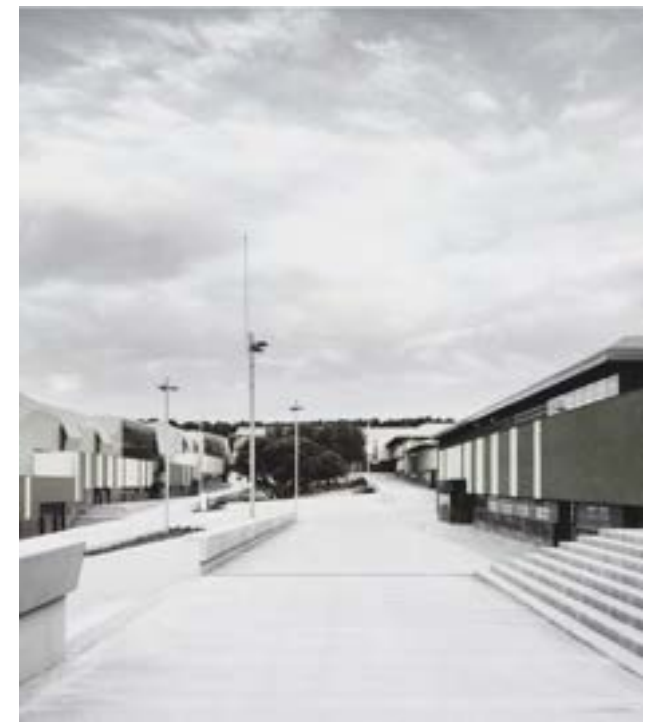
Fig. 09. Centro Penitenciario El Catllat, 2012 Fuente: José Hevia
