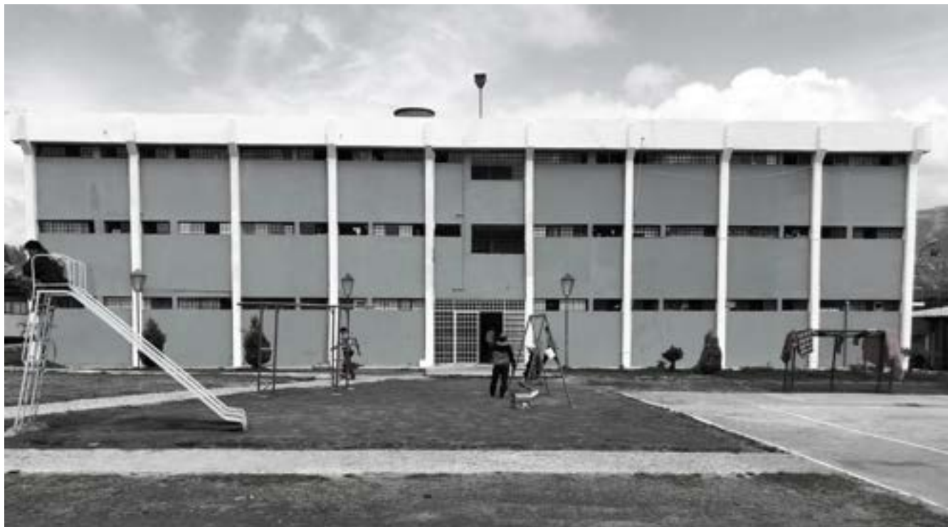
Fig. 69. Boque de celdas Fuente: Autoría propia
