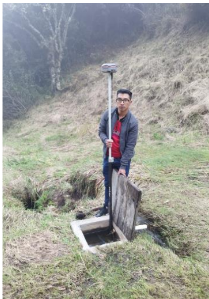
Figura 4. Captación de pallica
