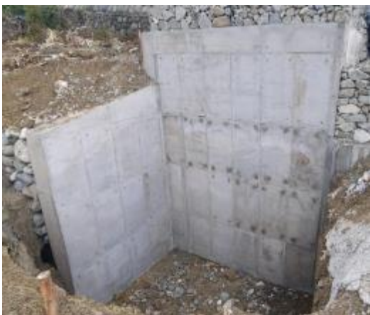
Muro de contención en Chaullabamba-Cuenca
