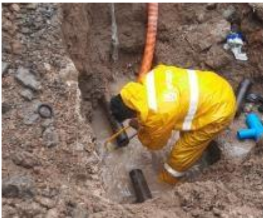
Arreglo de matiz y conexión a un nuevo sistema de agua potable
