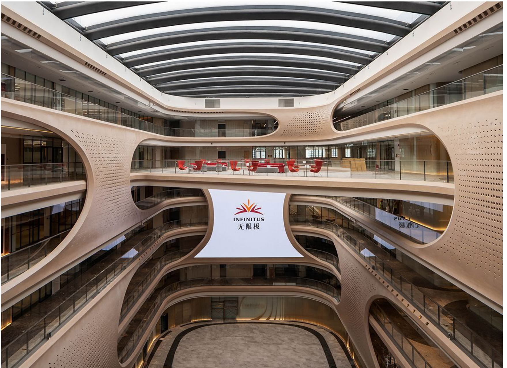
Imagen 12. Vista interior Infinitus Plaza Fuente: Zaha Hadid Architects, 2021
