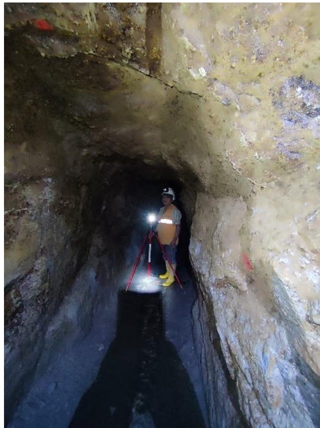
Figura 15. Galería principal de la mina
