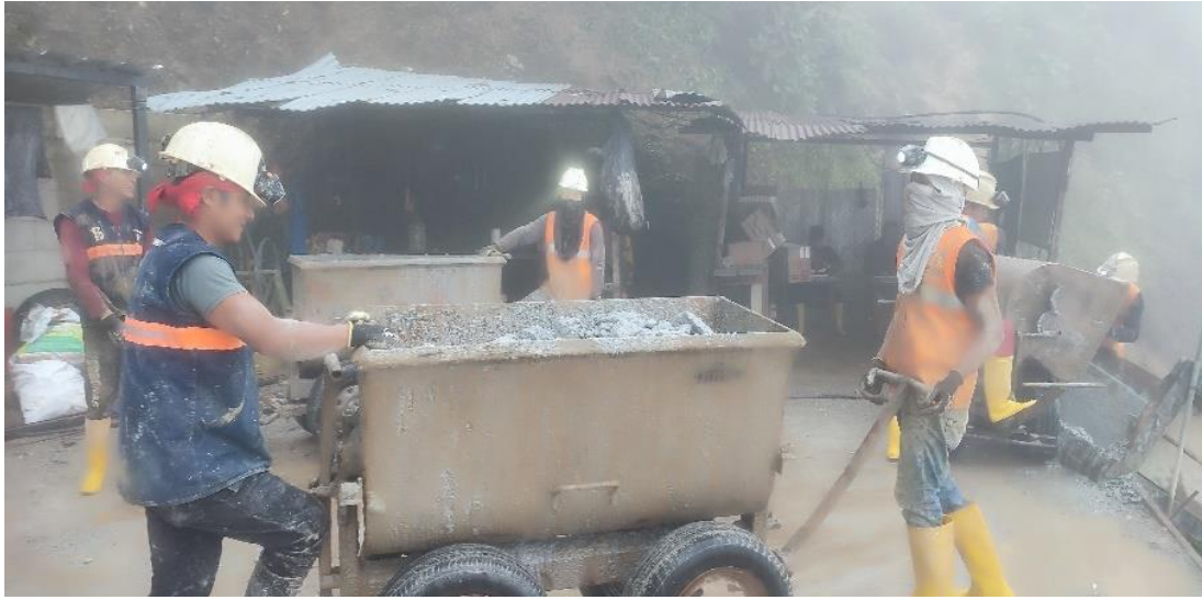
Figura 13. Maquinaria utilizada para la actividad minera
