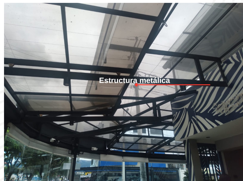
Figura 60: Fotografía primer piso. Vista de la cubierta. Elaboración propia.
