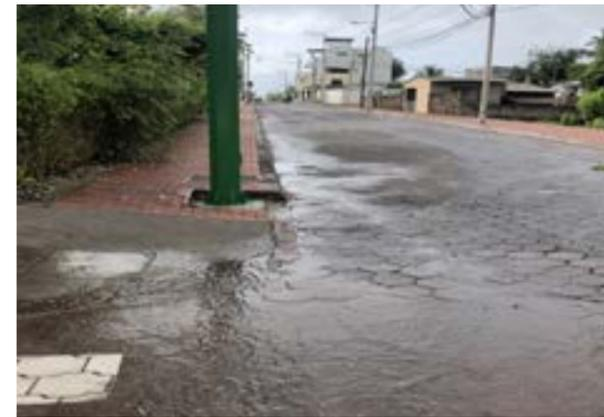
Fig. 76: Falla de alcantarillado. Fuente: Autoría propia
