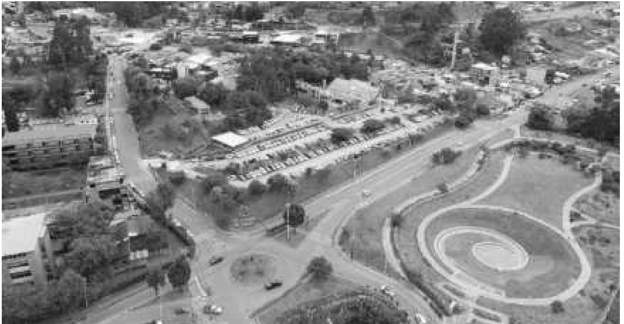
Estado Actual Parqueadero Universidad del Azuay
