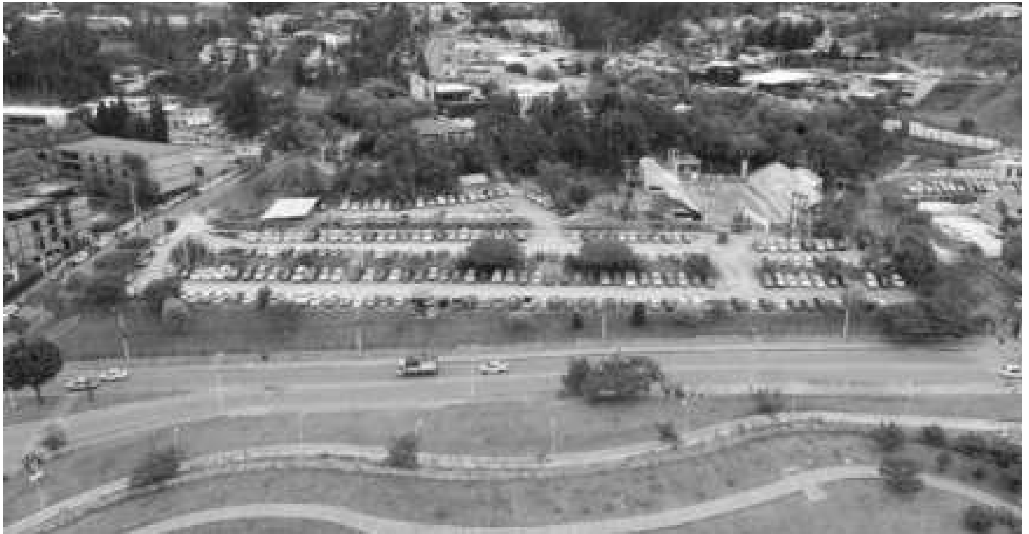
Estado Actual Parqueadero Universidad del Azuay
