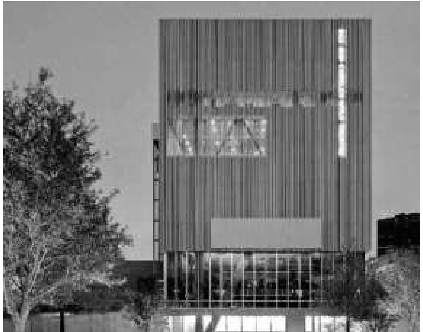
Fig. 83 Fotografía del Teatro Dee and Charles Wyly. Extraído de sitio web: https://www3.arquitecturaviva.com/obras/teatro-dee-y-charles-wyly
