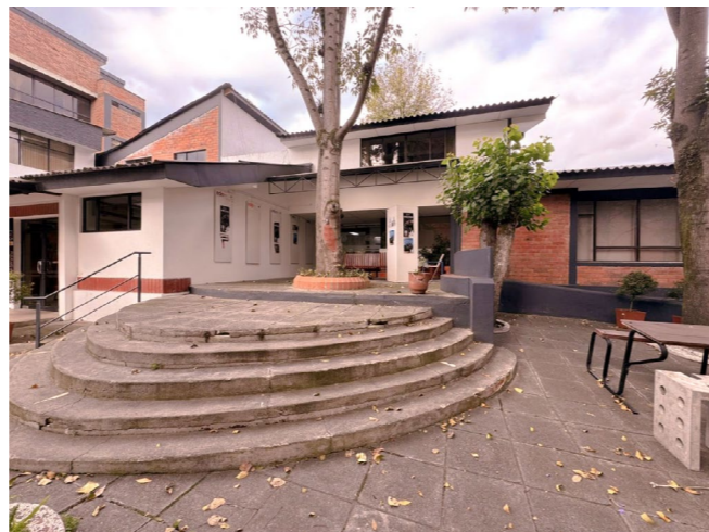
Fig. 55: Edificio de Administración. Fuente: Elaboración propia.
