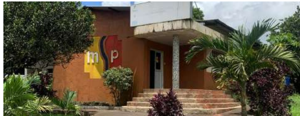
Vista del Centro de Salud
