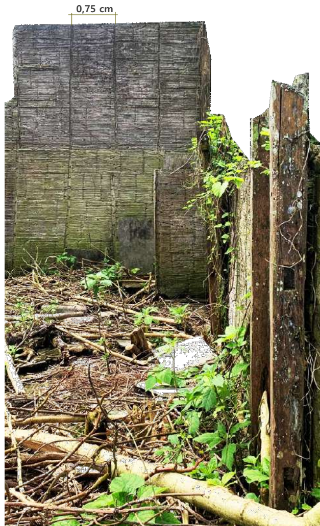
Materiales utilizados: latillas, alambre de púas y una capa de cemento.
