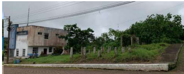
Vista hacia el sitio 2 a intervenir
