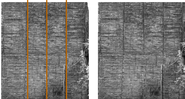
Sistema modular con un acabado natural en el interior, donde se pueden apreciar las vetas de la latilla.
