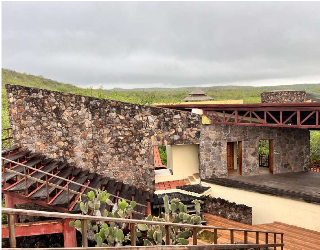
Exteriores del centro de Interpretación Ambiental Gianni Arismendy, Galápagos. Fuente: Autoría propia (2024) IMG 09
