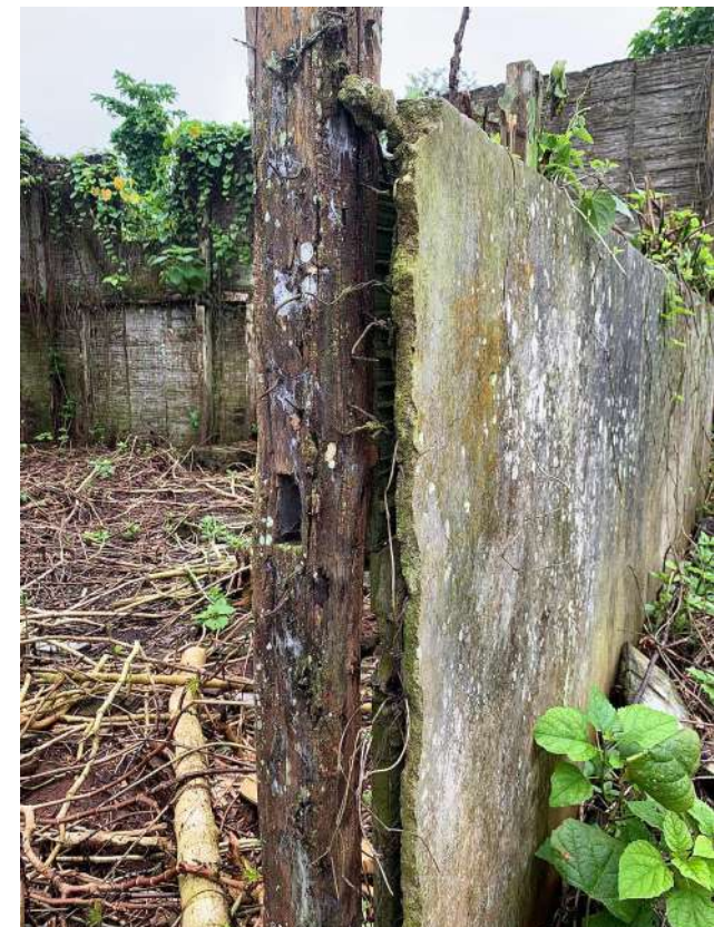
Materiales utilizados: latillas, alambre de púas y una capa de cemento.
