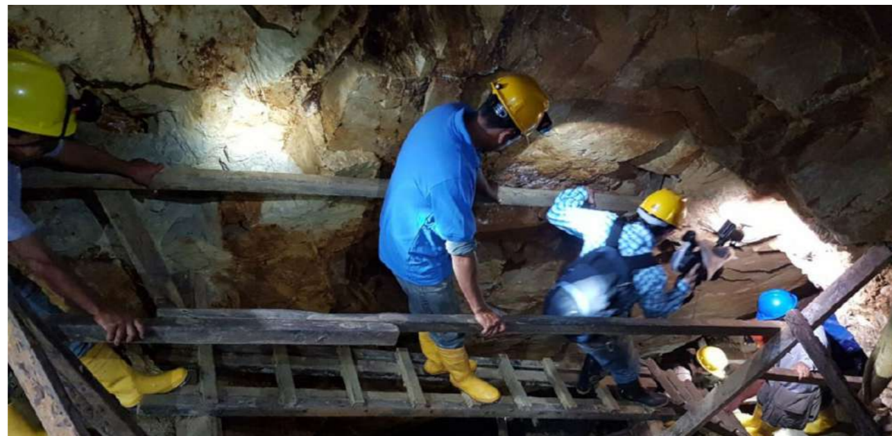
Fig 13. Galerías subsuelo del centro histórico de Zaruma. Fuente: El Universo, 2022.
