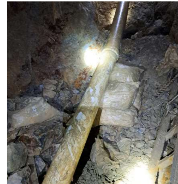
Fig 14. Etapa de remediación, tubo desde la superficie Fuente: Anonima, 2022.
