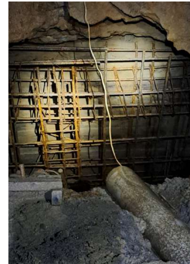
Fig 15. Etapa de remediación, tapón en galería Fuente: Anonima, 2022.
