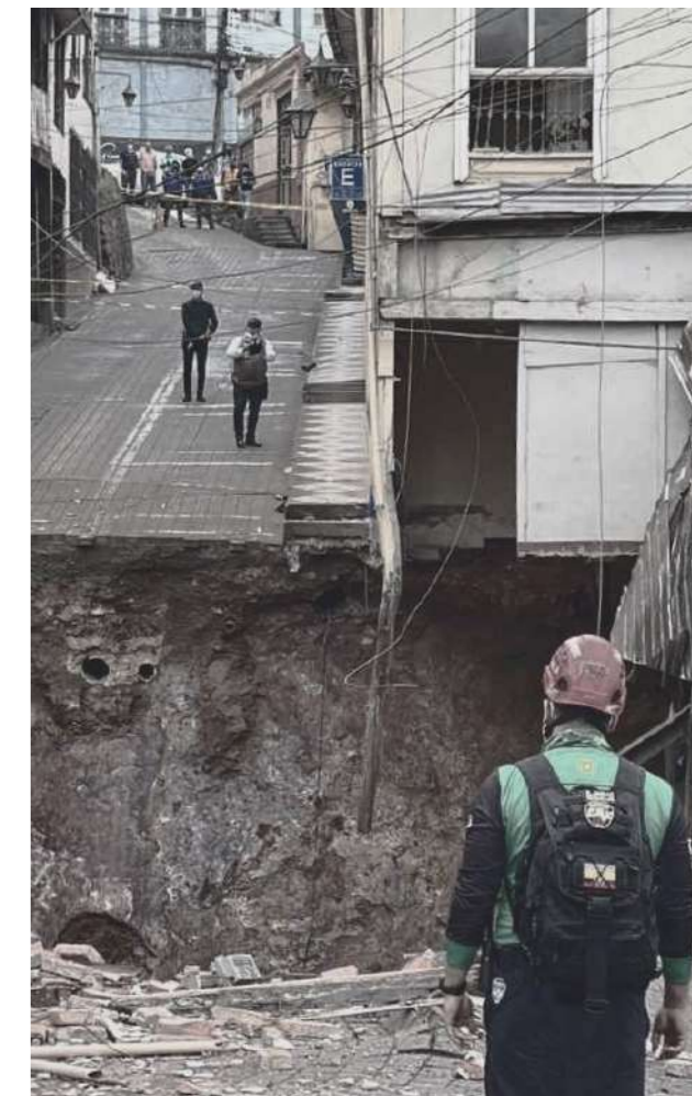
Fig 2. Socavón calle Colón. Fuente: El Diario, 2021.
