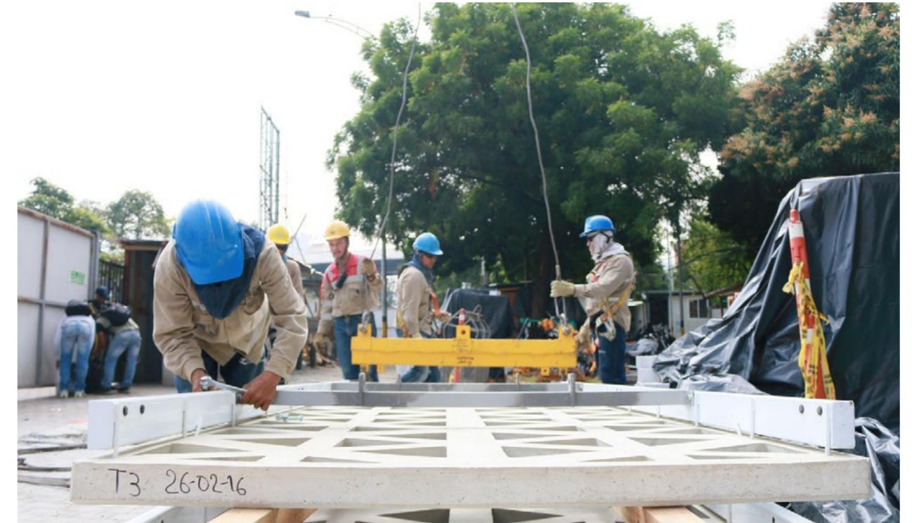
Img 11. Proceso de anclaje de Glass Reinforced Concrete. Fuente: Alejandro Arango.
