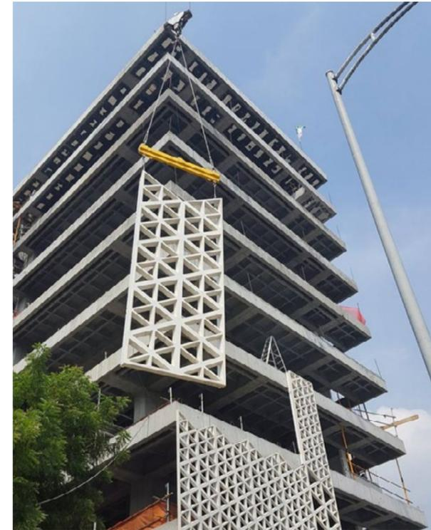
Img 07. Montaje de envolventes prefabricadas: Fuente: Alejandro Arango.
