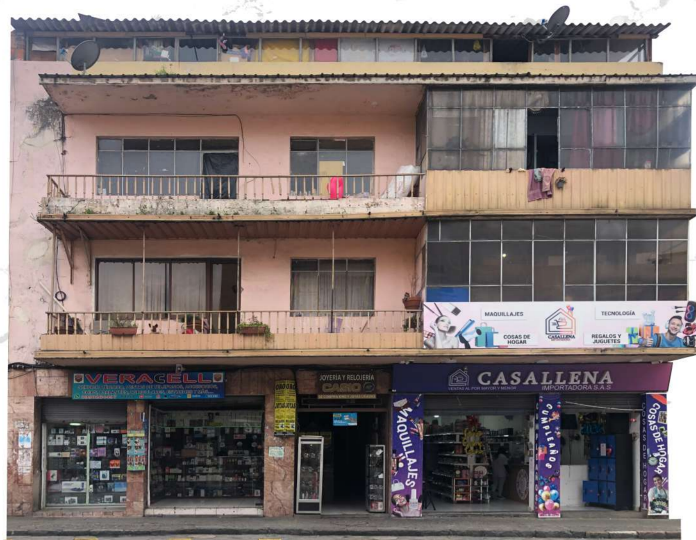
ESTADO ACTUAL FACHADA PRINCIPAL
