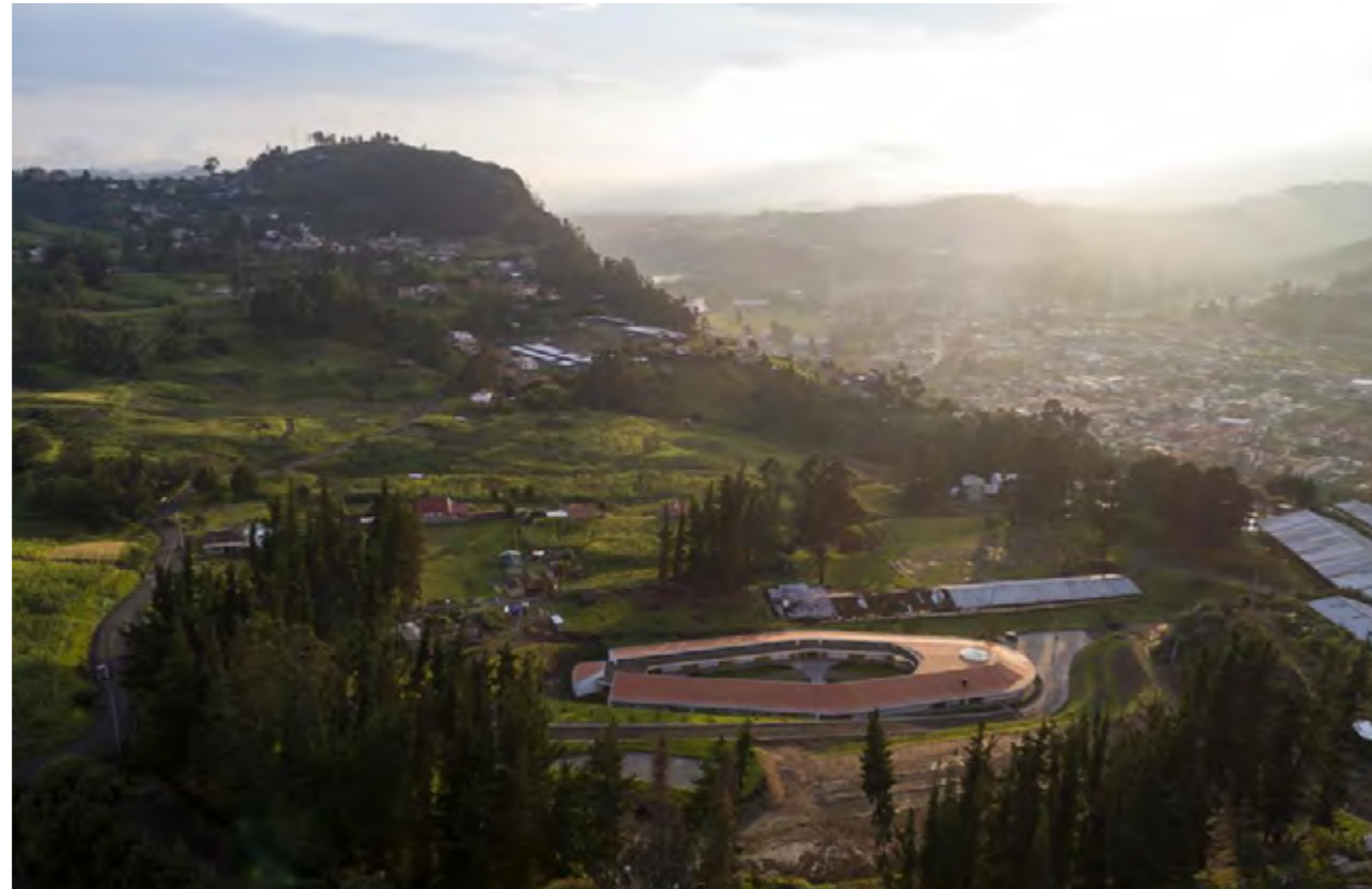
Fuente: Taller Alexis Schulman (2021) Figura 30: Vista panorámica del Centro
