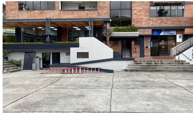
Figura 88. Fotografía actual, entrada al bloque de servicios UDA.
