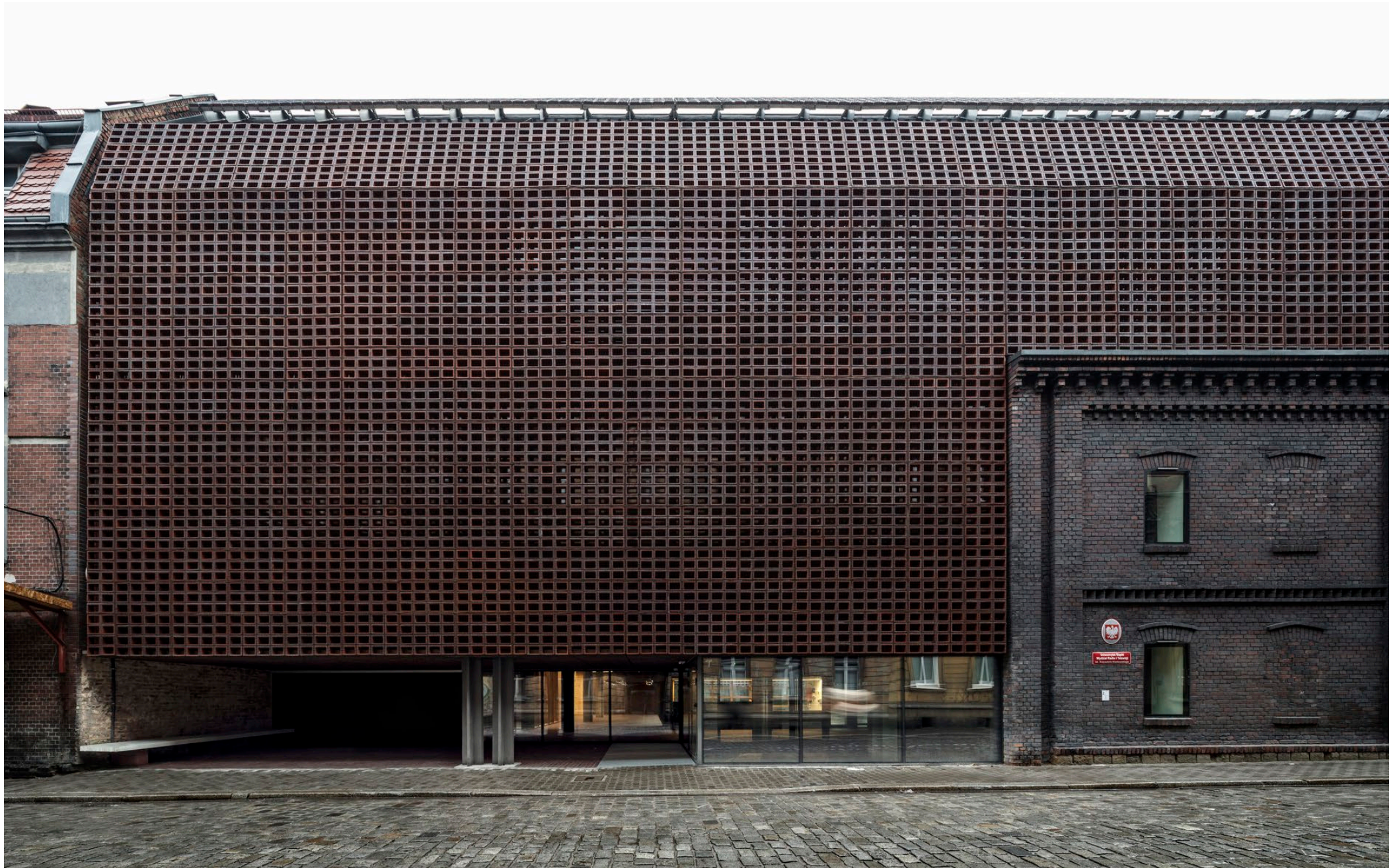
Figura 22. Fachada frontal Dep. de radio y televisión de la universidad de Silesia.
