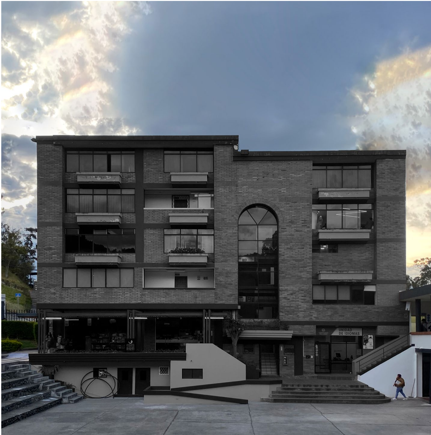
Figura 01, Estado actual del bloque de servicios de la Universidad del Azuay.
