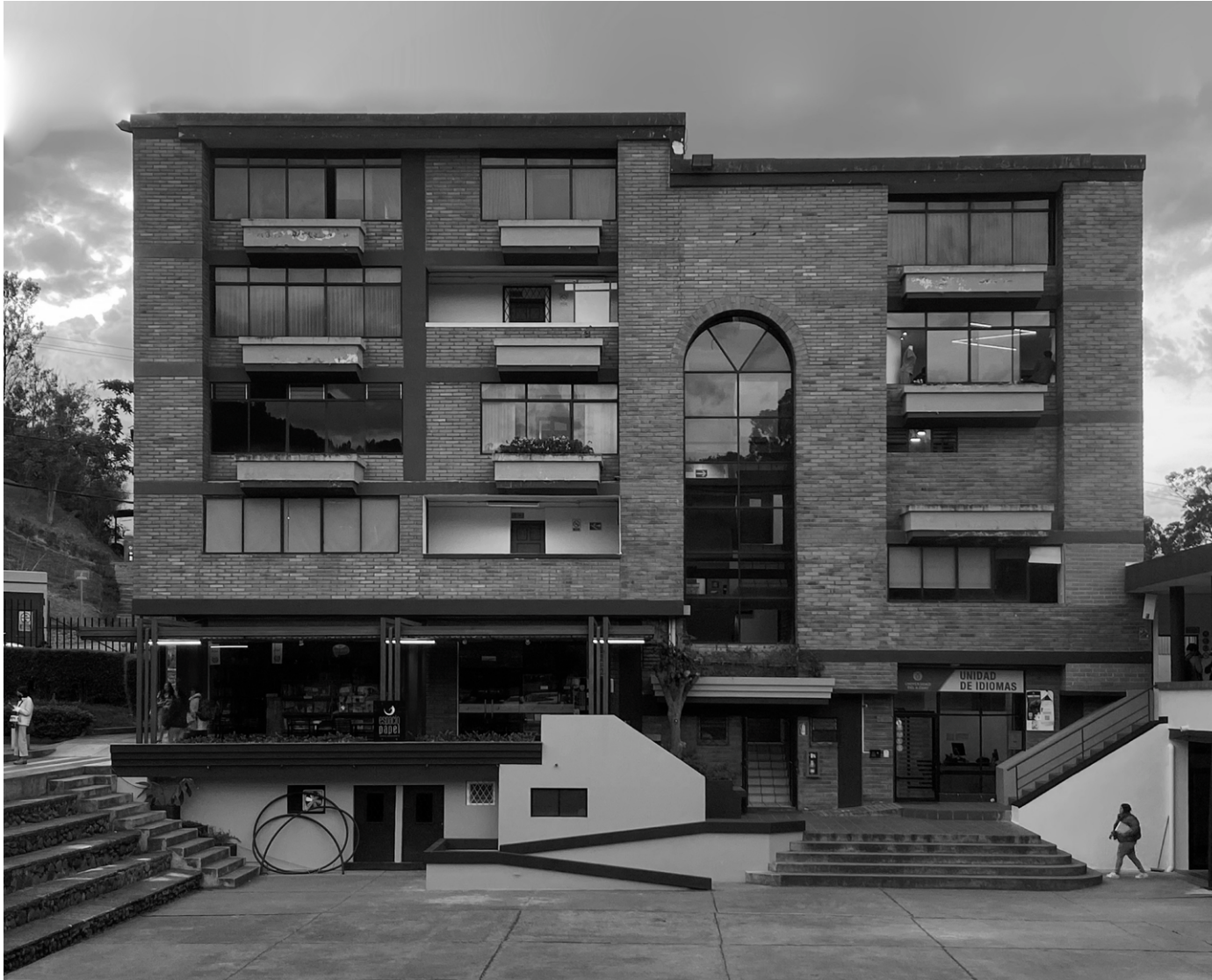
Figura 01, Estado actual del bloque de servicios de la Universidad del Azuay.
