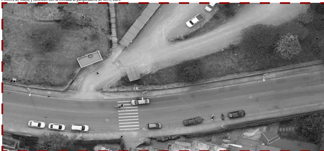
Figura 120. Estado actual, plataforma única, entrada lateral, Calle Hemán Malo.
