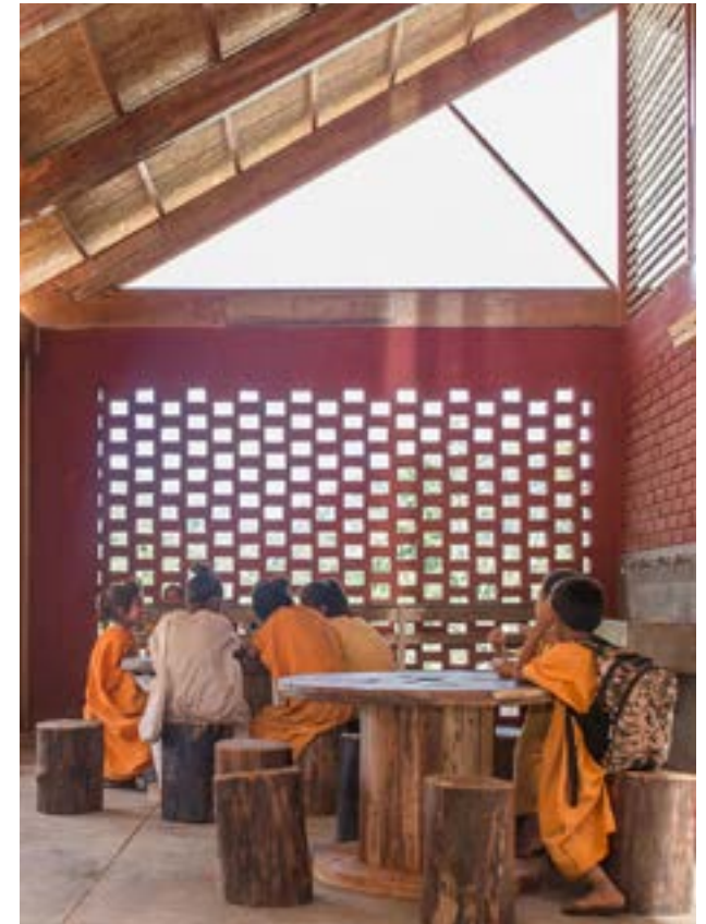
Img 33. Uso del recurso de mamposterías con ladrillos artesanales que genera una sensación de identidad en los espacios. Fuente: Cuadros, E. (s.f.)
