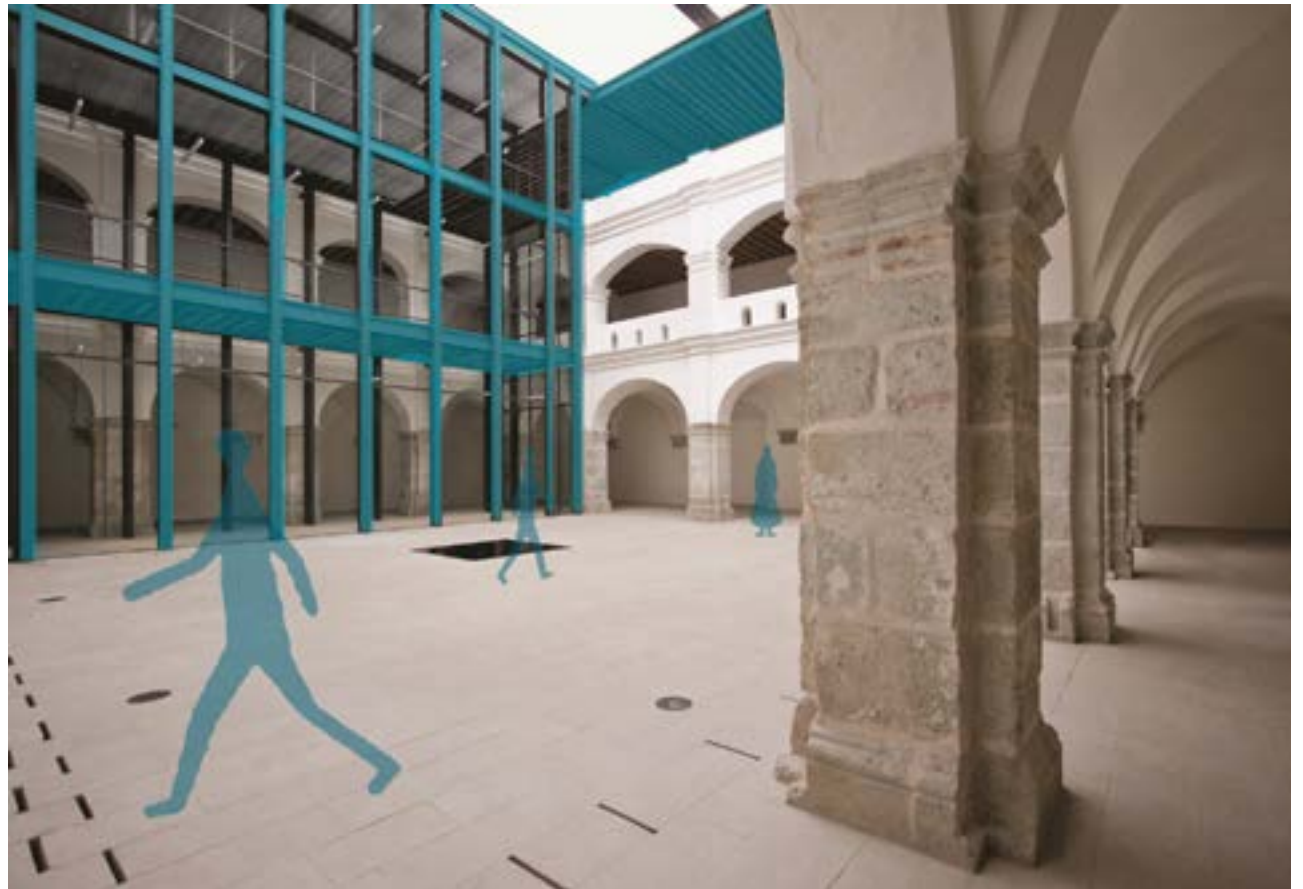
Img 03. Estructura reciclada y añadida para un nuevo uso en el monasterio. Fuente: León, F. (2012)
