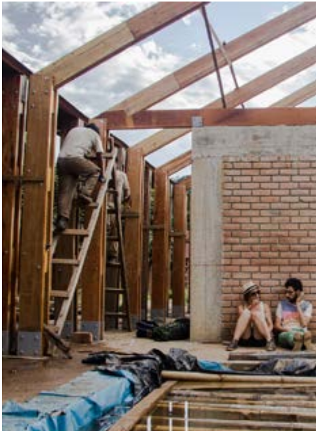
Img 31. Sistema constructivo a base la madera y materiales de la zona. Fuente: Cuadros, E. (s.f.)
