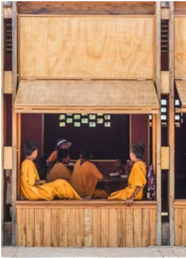
Img 24. Ventanas plegables y dinámicas para el usuario que permiten la ventilación y el uso de materiales de la zona. Fuente: Cuadros, E. (s.f.)
