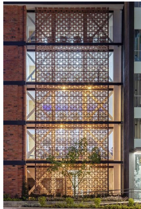
Fig.25. Celosías de Mampostería Fuente BAQ 2022
