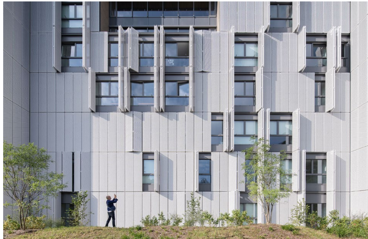
Fig.13. Fachada Dinamica edificio Gran Morillon Fuente ArchDaily
