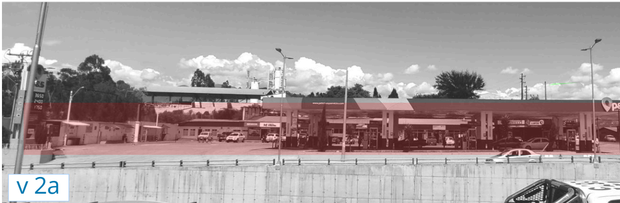
Visual 2. Fachada frontal en la parte central del paso deprimido.
