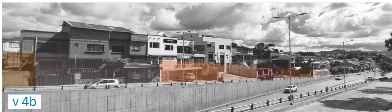
Visual 4b. Panorámica del tramo 2 en la parte central del paso deprimido.
