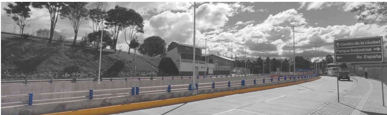
Imagen 12. Foto propia. Parque Virgen de Lourdes. Paso deprimido Milchichig
