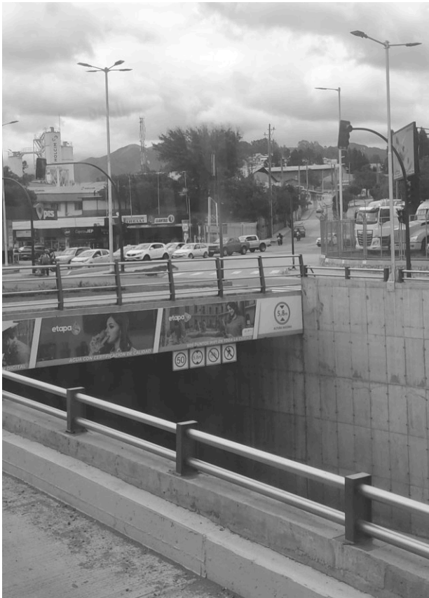
Imagen 8. Foto propia (2023). Paso a desnivel de Milchichig
