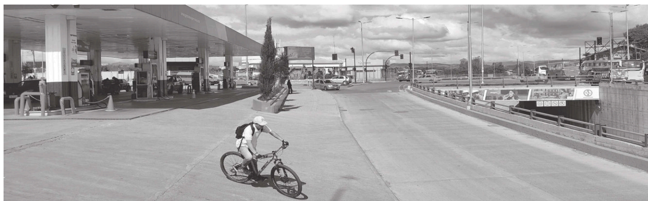
Imagen 11. Foto propia. Bomba de los choferes - Paso deprimido Milchichig
