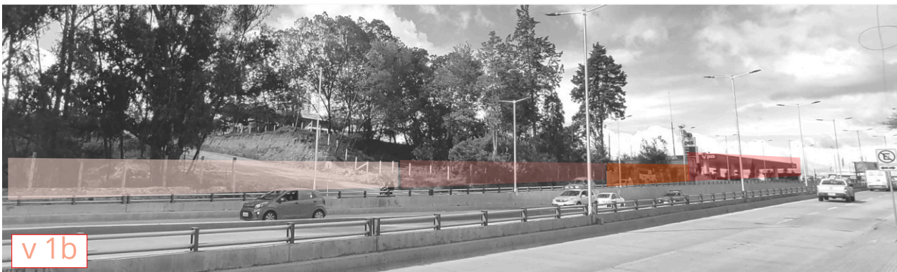
Visual 1. Foto panorámica de manzana en la parte inicial del paso deprimido.
