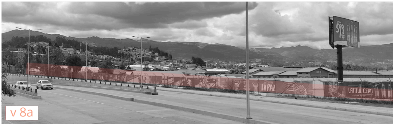
Visual 8a. Fachadas del tramo 4 en la parte baja del paso deprimido. Hacia el Parque Industrial
