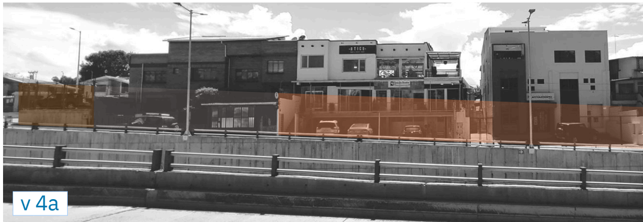
Visual 4a. Fachadas del tramo 2 en la parte central del paso deprimido.
