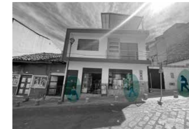
Figura C4, 14: Cero obstáculos en tramo A-B
