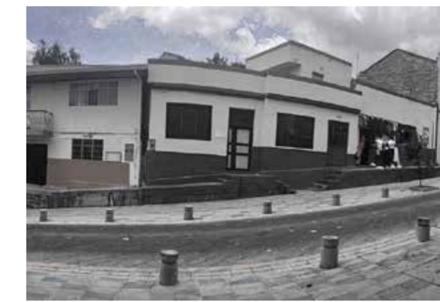
Figura C2, 04: Ausencia red de bicicletas, tramo B-C
