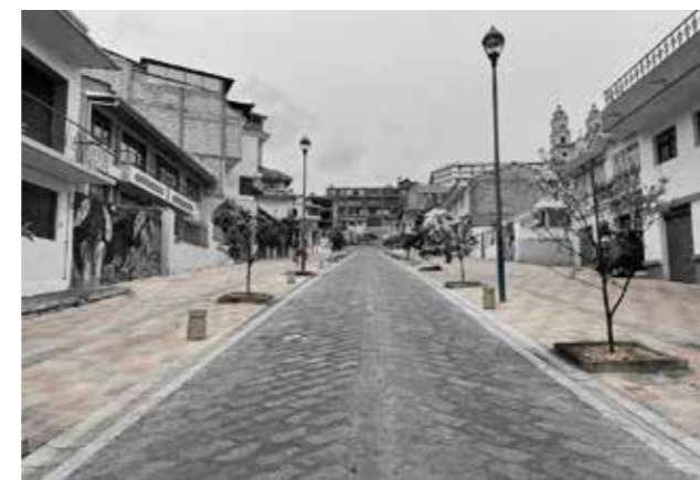
Figura C4, 02: Veredas, tramo B-C
