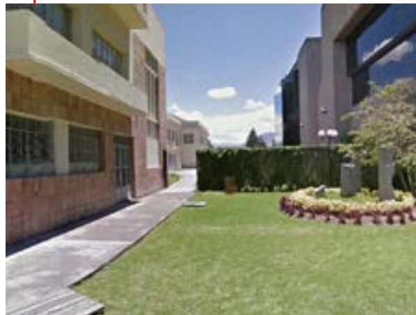
6 Vista lateral hacia el oeste, se observa el camino peatonal que separa al excolegio Borja del Museo Pumapungo.
