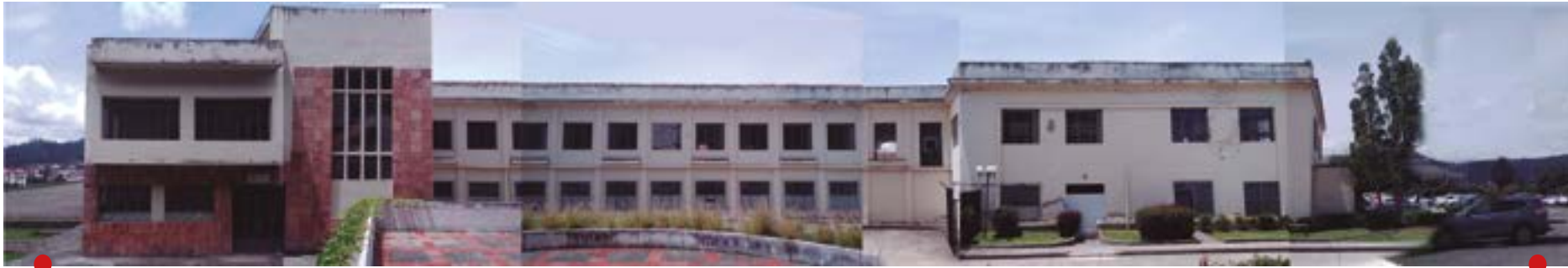
5 Fachada frontal norte del excolegio Borja armada mediante fotomosaico determinando una longitud de emplazamiento de 70 metros por 11,25 de altura
