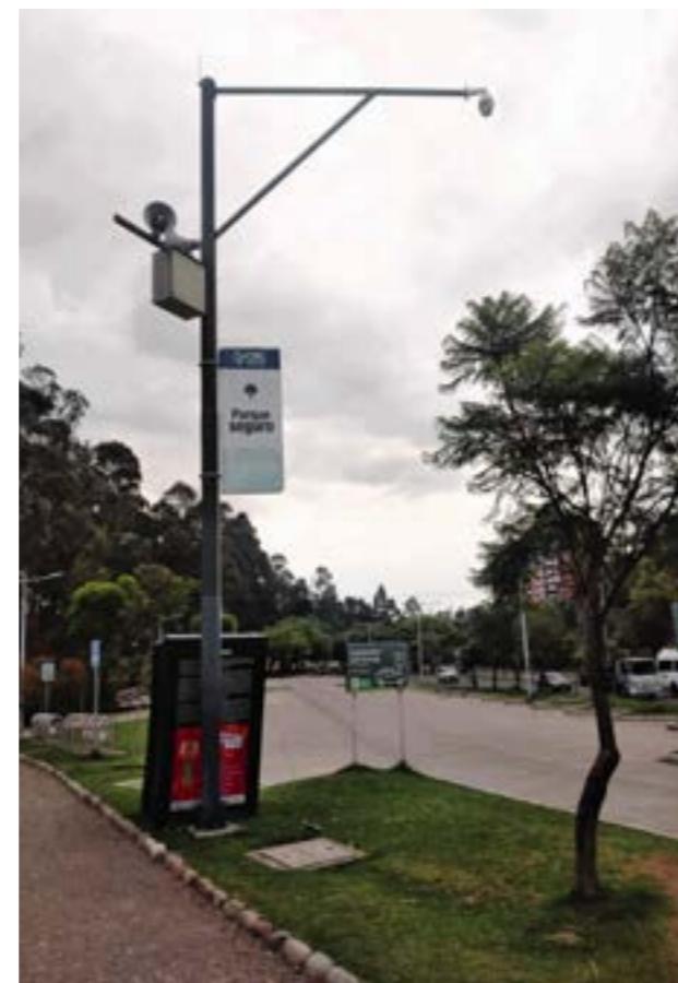
Fig. 05 Dispositivo de seguridad, Parque Tarqui-Guzho Fuente: Propia
