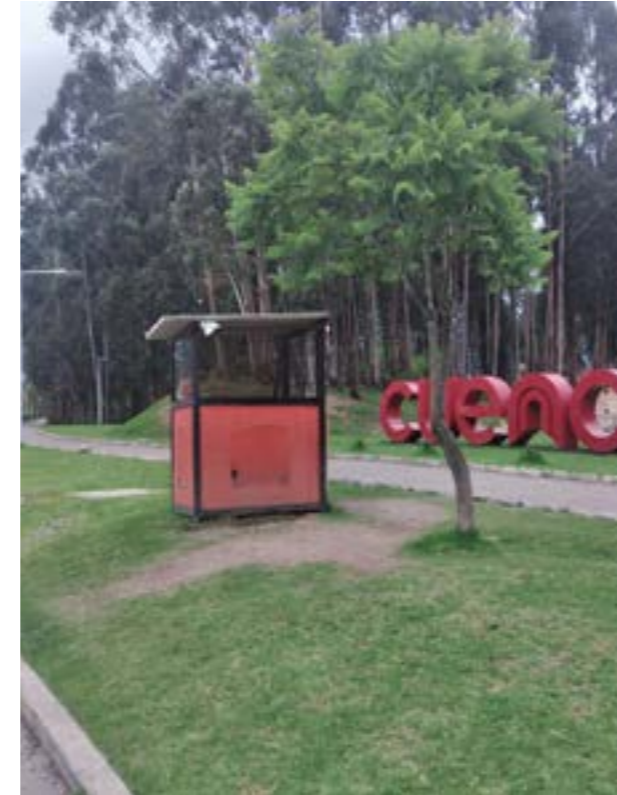
Fig. 43 Guardianía Parque Tarqui-Guzho Fuente: Propia
