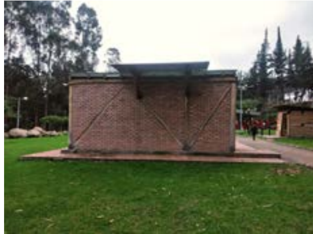
Fig. 37 Bloque de servicios Tarqui-Guzho Fuente: Propia
