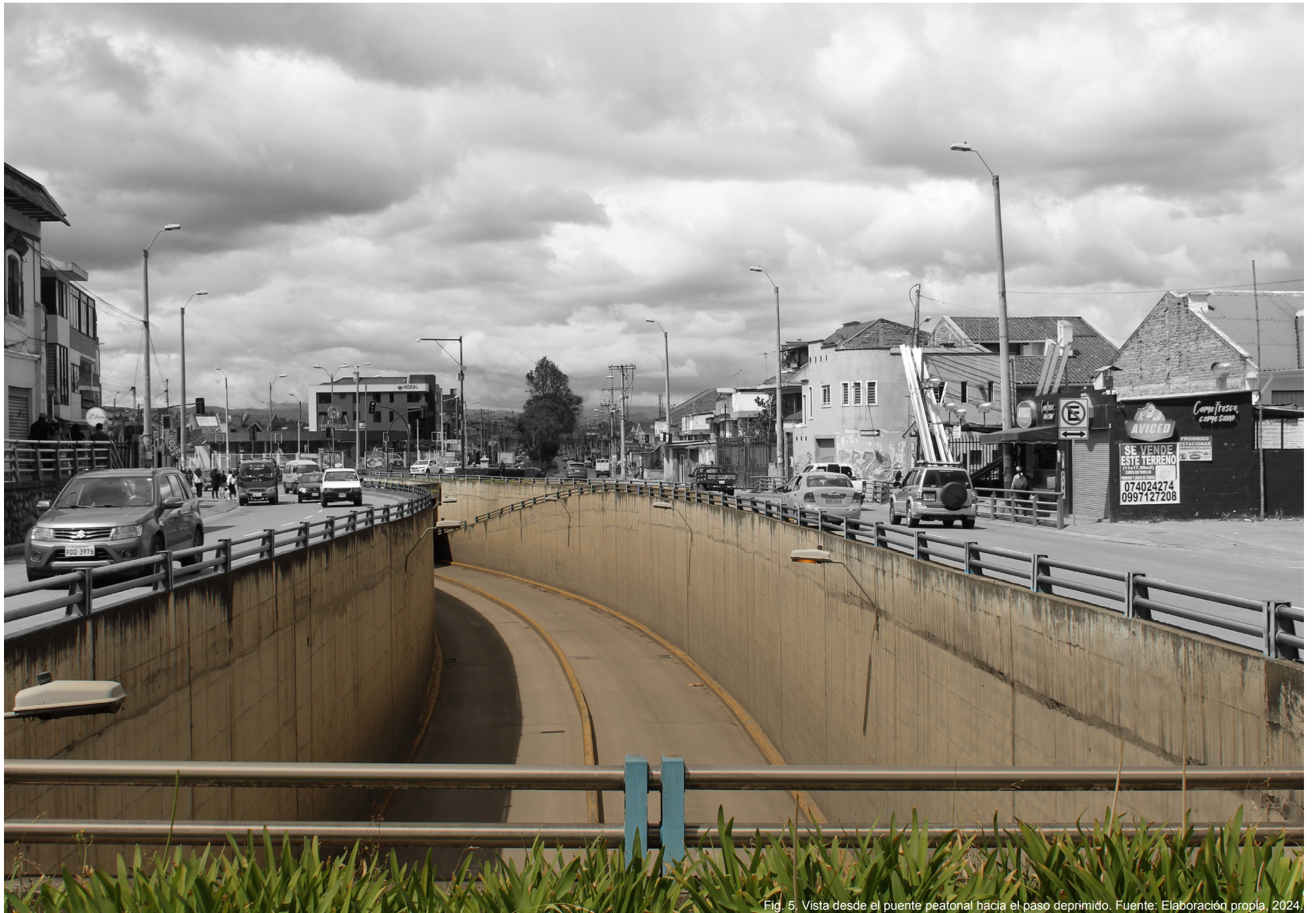
Fig. 5. Vista desde el puente peatonal hacia el paso deprimido. Fuente: Elaboración propia, 2024.
