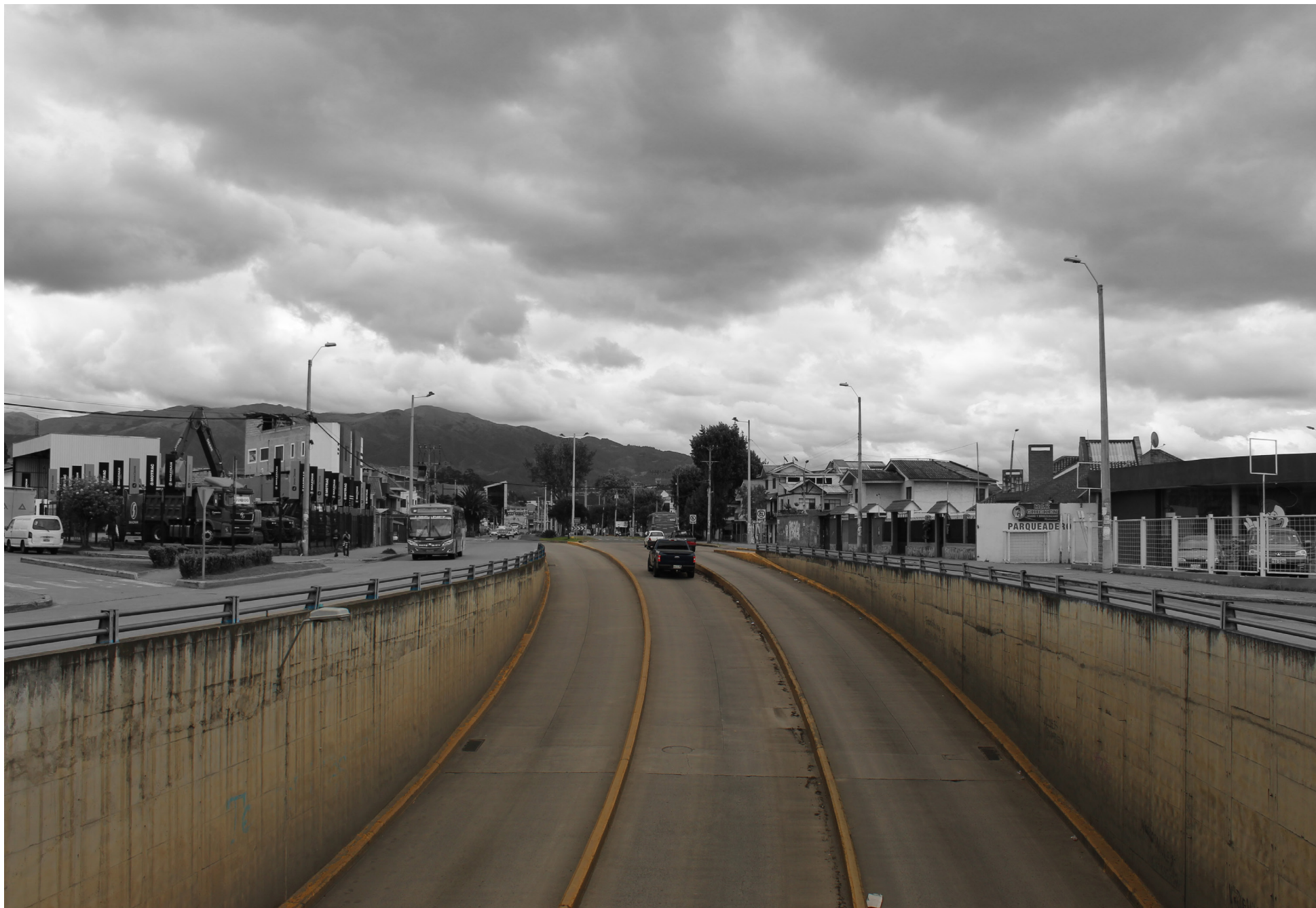
Fig. 42. Paso deprimido salida hacia la Av. las Américas. Fuente: Elaboración propia, 2024.
