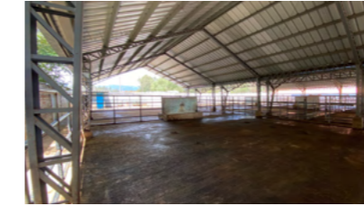
Fig. 33. Vista interna. Fuente: Autoría propia.
