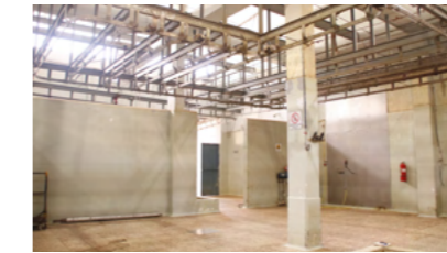
Fig. 36. Vista interna. Fuente: Autoría propia.
