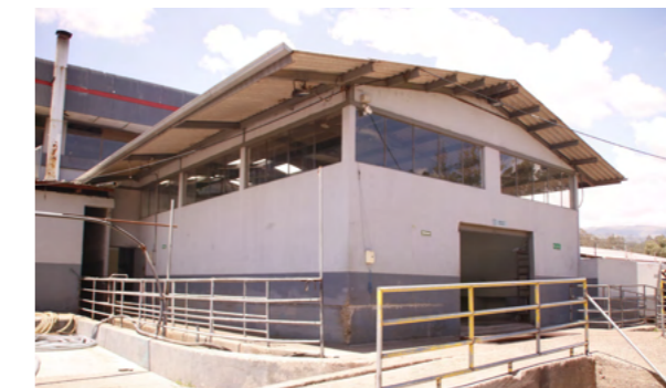
Fig. 44. Ampliación de planta de faenamiento. Fuente: Autoría propia.
