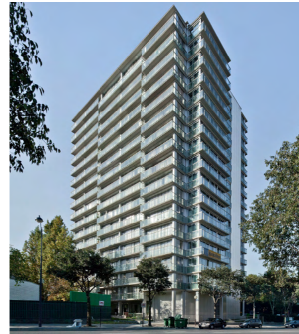
Fig. 21. Fotografía exterior del proyecto. Fuente: Atlas of places.
