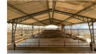
Fig. 34. Vista interna. Fuente: Autoría propia.
