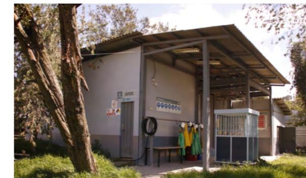
Fig. 43. Planta de rostizado. Fuente: Autoría propia.
