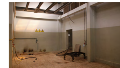
Fig. 38. Vista interna. Fuente: Autoría propia.
