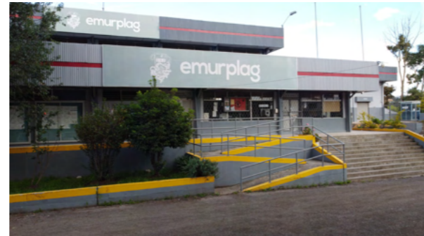
Fig. 48. Desnivel interno en las instalaciones. Fuente: Autoría propia.
