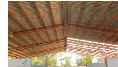
Fig. 35. Vista interna. Fuente: Autoría propia.
