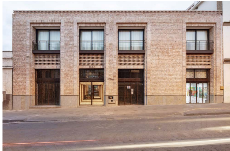
Fig 20: Casa del Ciprés Fuente: BICUBIK. (2020). Casa del Ciprés [Image]. Recuperado de https://www.bicubik.photo/projects/casas-del-cipres/
