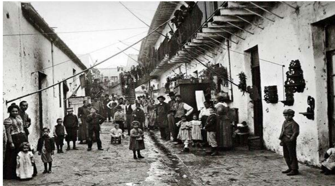
Fig 05: Vivienda urbana colectiva de Argentina Fuente: Museo Virtual del Centenario Argentino (20202).Recuperado de: Pacarina del Sur - https://pacarinadelsur.com/home/abordajes-y-contiendas/1941-politicas-habitacionales-y-dictadura-sanitaria-en-los-conventillos-de-buenos-aires
