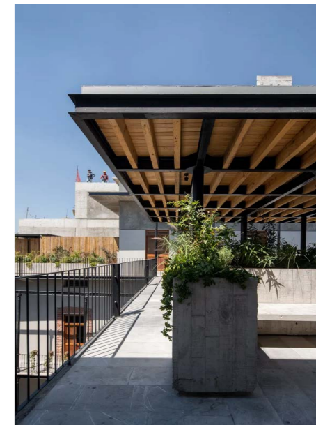
Fig 34: Espacio interior Fuente: Reurbano. (2024). Casa Emilio Dondé 7 [Image]. Recuperado de https://casaemiliodonde7.reurbano.mx/
