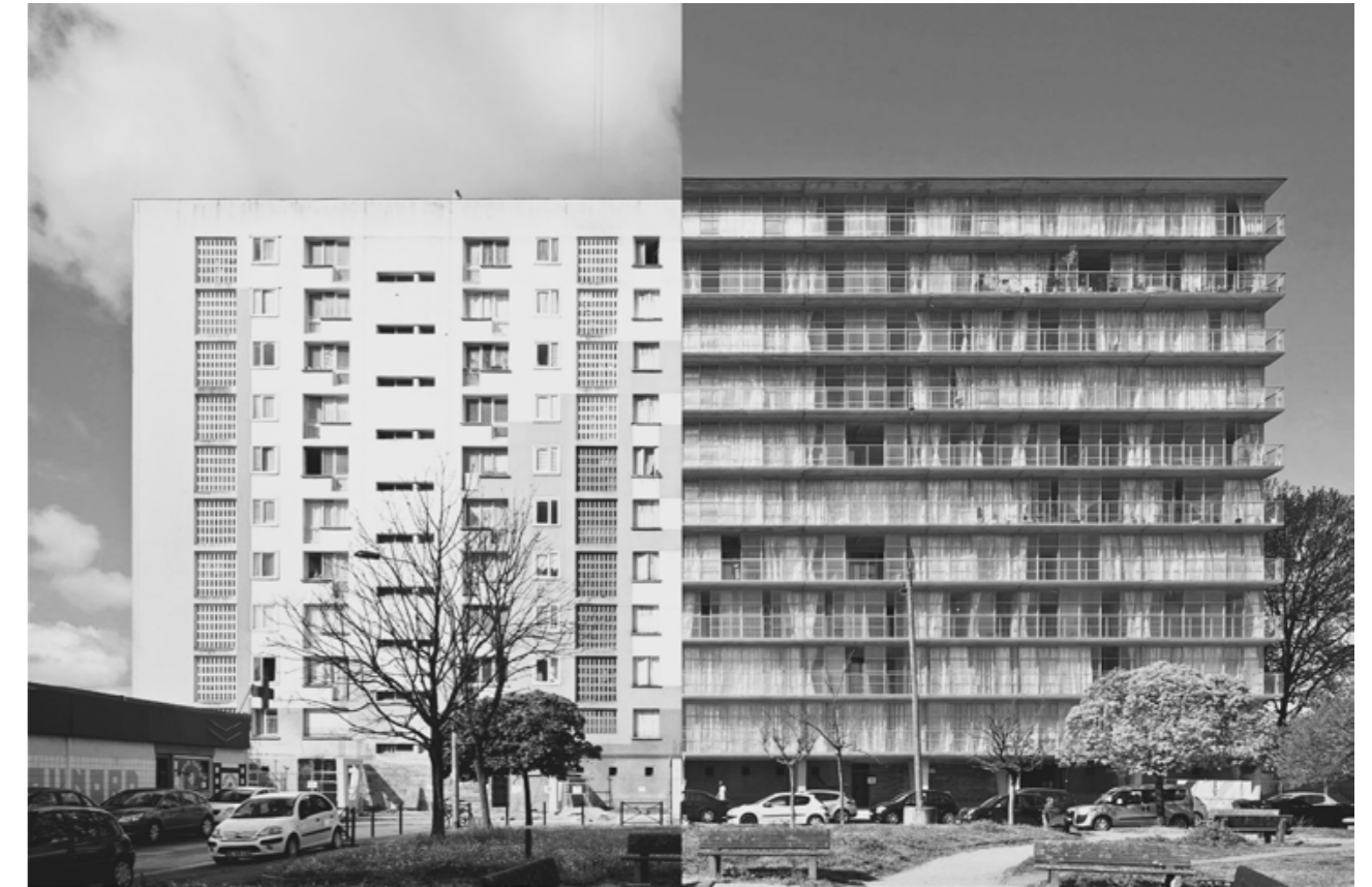
Fig.14. Rehabilitación de Social Housing en Bordeaux, Francia. Fuente: Philippe Ruault.
