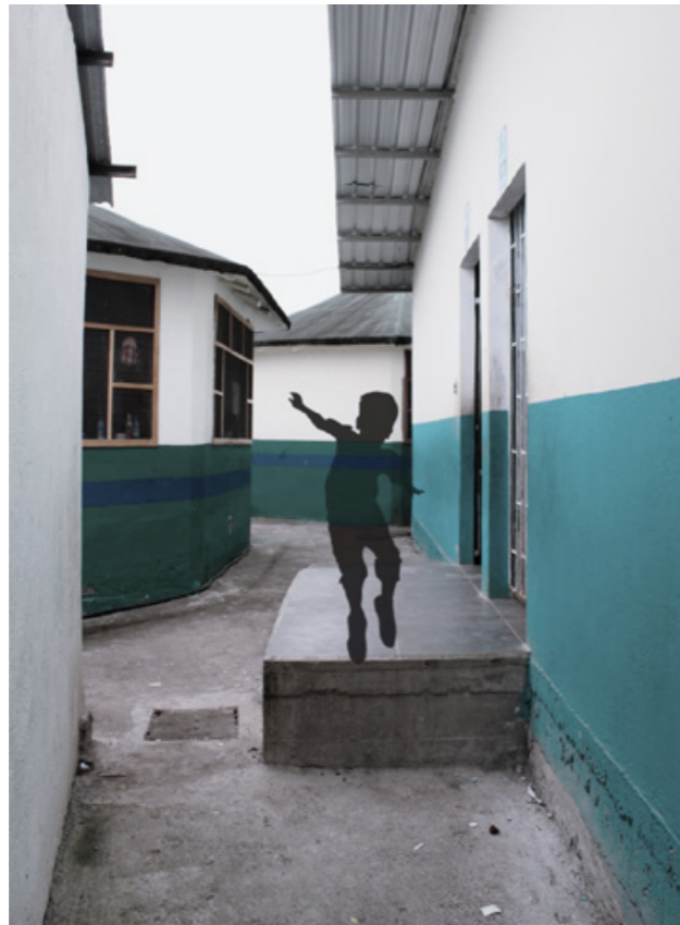
Fig.99. Bloque de baños 1. Fuente: Propia.
