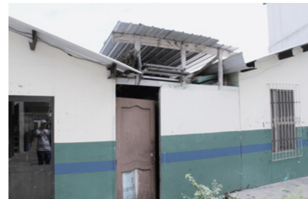
Fig.106. Bloque de baños 1. Fuente: Propia.
