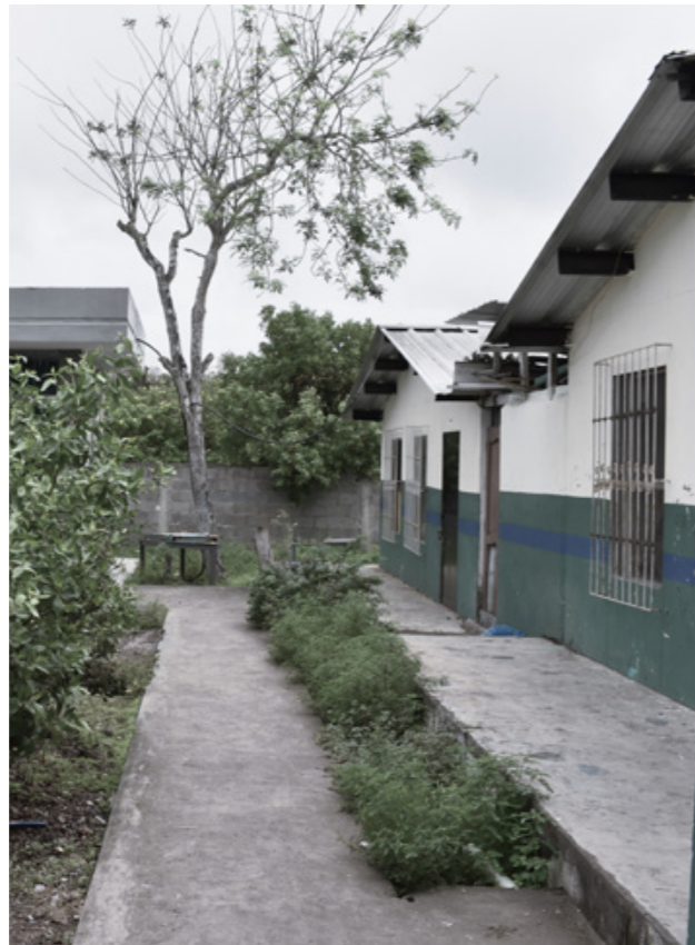
Fig.104. Bloque de baños 1. Fuente: Propia.
