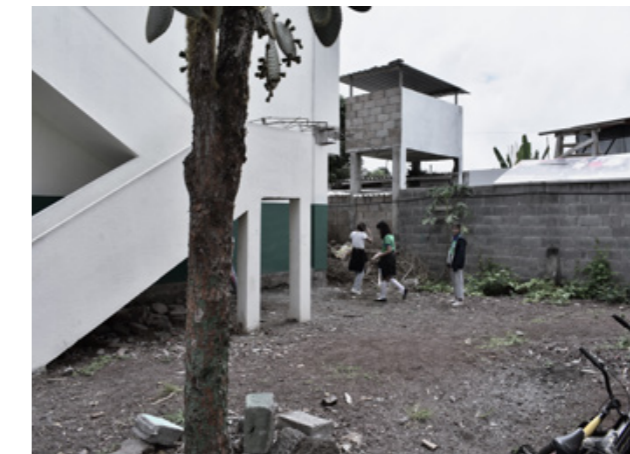
Fig.108. Espacio hueco entre los bloques. Fuente: Propia.
