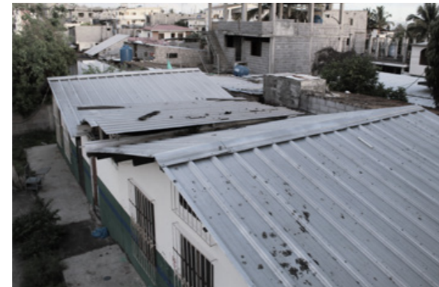
Fig.105. Bloque de baños 1. Fuente: Propia.
