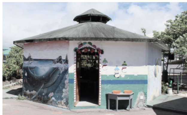
Fig.94. Aula Inicial 1 A Fuente: Propia.
