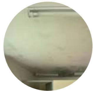
Cielo raso falso con paneles de yeso cartón
