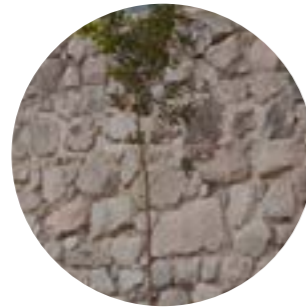
Cimentación Muros de contención de piedra del lugar
