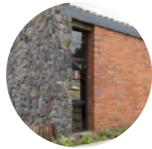
Muros Mamposterías de ladrillo de la zona Paredes de piedra volcánica
