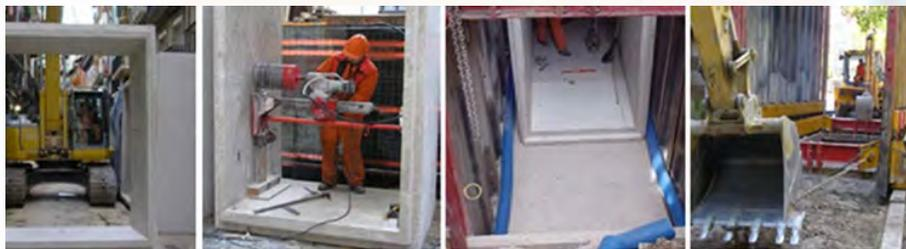
Imagen 1 Procedimiento para instalar módulos prefabricados y mover la entibadora.
