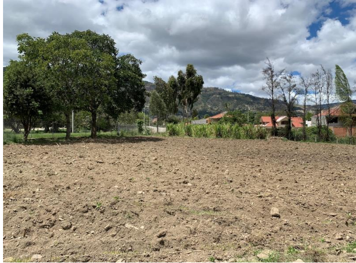
Ilustración 7 Preparación del terreno
