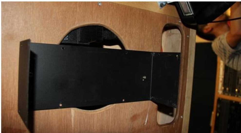
Fotografía 1: Aquí se aprecia cómo se fijó la caja de nuestro equipo en la mesa de la consola de radio.
