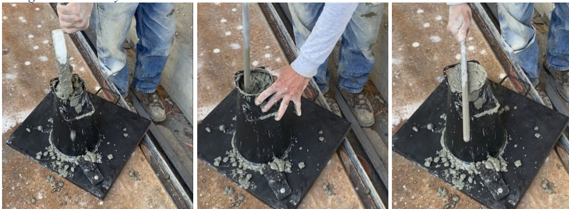
Figura 3.51: Ensayo de asentamiento utilizando el cono de Abrams.
