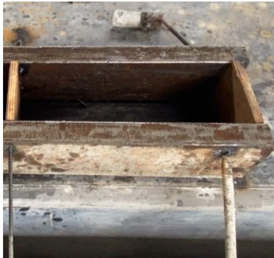
Figura 3.33: Colocación del encofrado.
