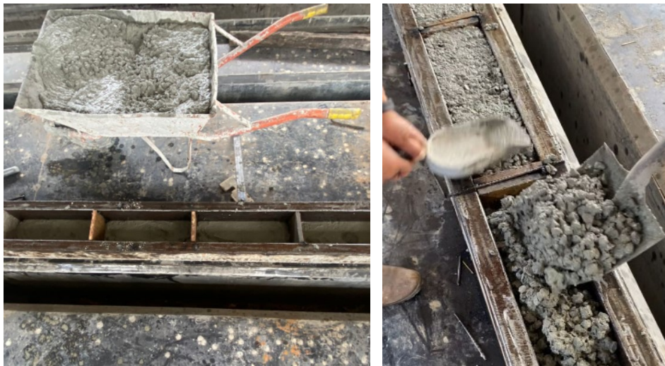
Figura 3.35: Elaboración de vigas con hormigón convencional.
