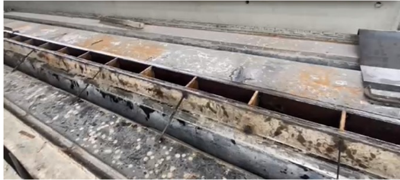
Figura 3.34: Distribución de encofrados.
