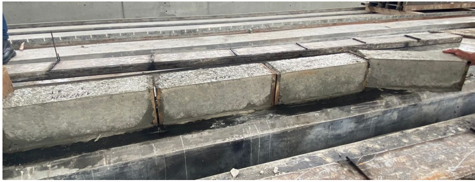
Figura 3.49: Desencofrado de vigas.
