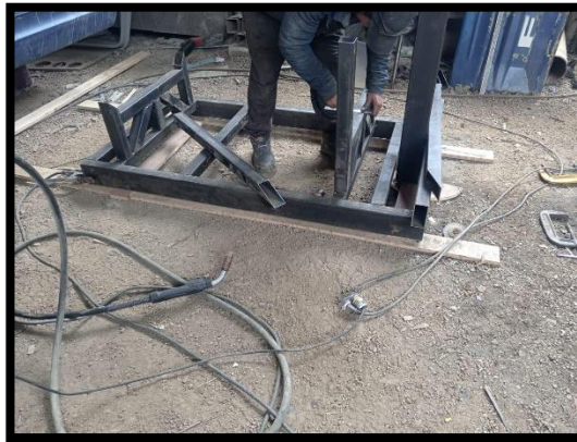
Imagen 7. Fijación de tubos
