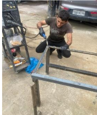
Figura 12. Proceso de soldado de la estructura
