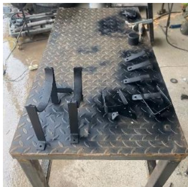
Figura 17. Lijamiento de soportes
