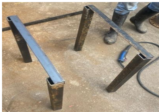
Figura 11. Proceso de soldado de la estructura
