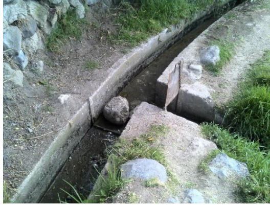
Figura 1.8. Derivación con compuertas
