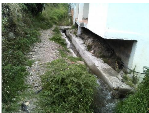
Figura 1.5. Canales de riego revestidos de hormigón simple
