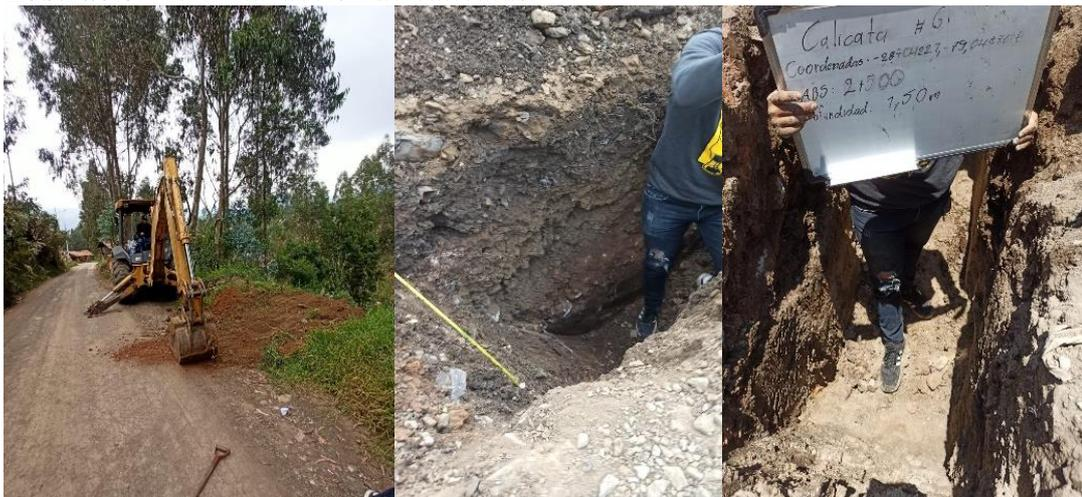
*Nota:* La imagen izquierda evidencia la maquinaria empleada para la excavación, la imagen central el resultado de la excavación realizada y la distribución de perfiles de suelo (visualmente), la imagen derecha representa la información tomada para ubicar las muestras.
