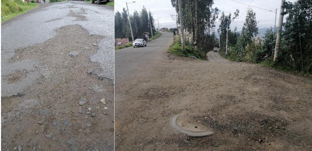
*Nota:* La imagen a la izquierda muestra el acabado a nivel de Doble Tratamiento Superficial Bituminoso (DBT), por otro lado, la imagen a la derecha nos muestra el acabado a nivel de Lastre.
