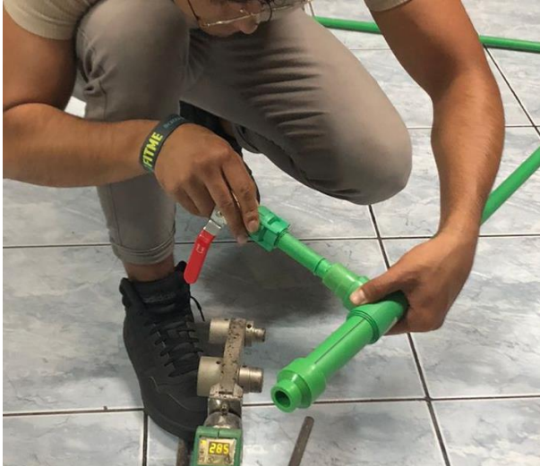
Figura 1.3 Unión de los accesorios a presión
