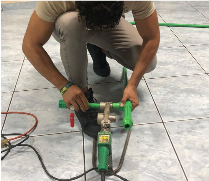
Figura 1.2 Calentamiento de los accesorios
