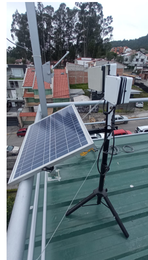
Figura 19. Instalación del prototipo en su etapa final.
